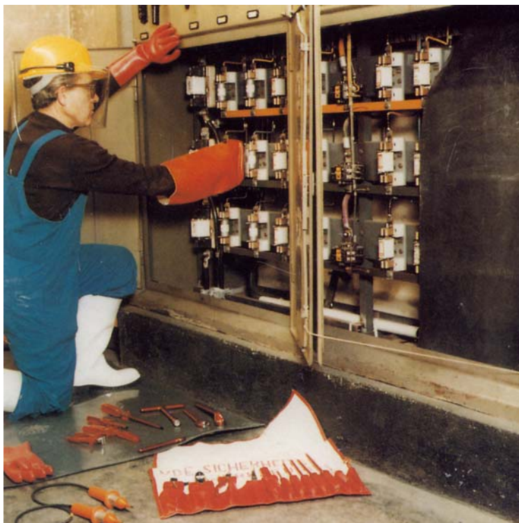
Abb. 5.6: Auswechseln von NH-Sicherungseinsätzen (siehe Anhang)
