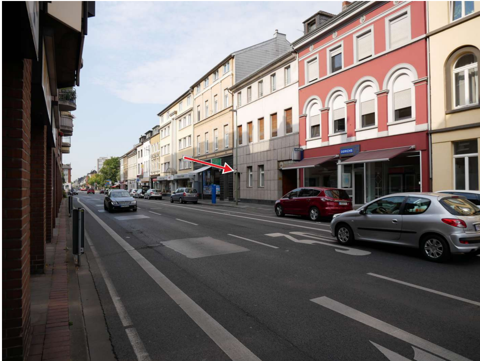
Abbildung 10: Zusätzliche Ansicht - Neuss Friedrichstraße 29 (Juli 2018)
