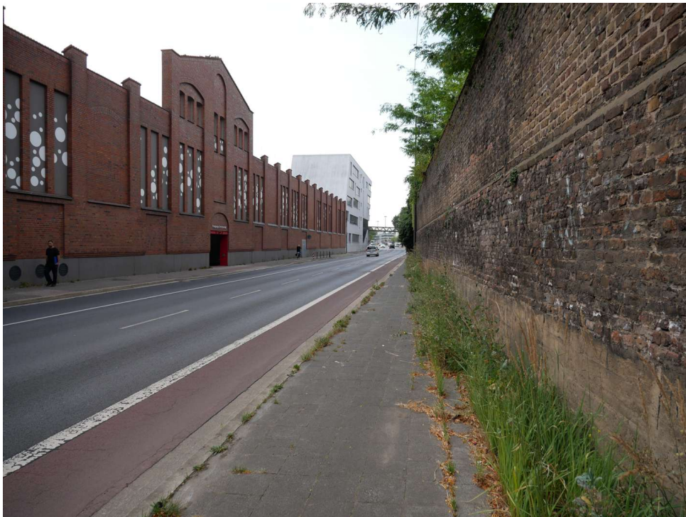
Abbildung 9: Zusätzliche Ansicht - Neuss Batteriestraße (Juli 2018)
