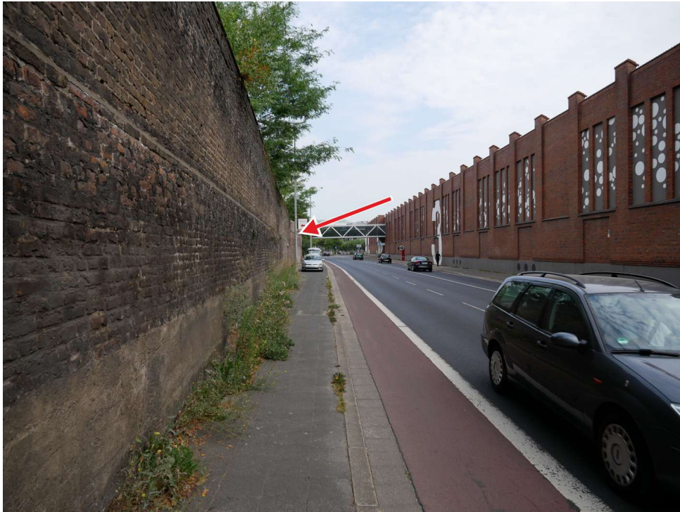
Abbildung 10: Zusätzliche Ansicht - Neuss Batteriestraße (Juli 2018)
