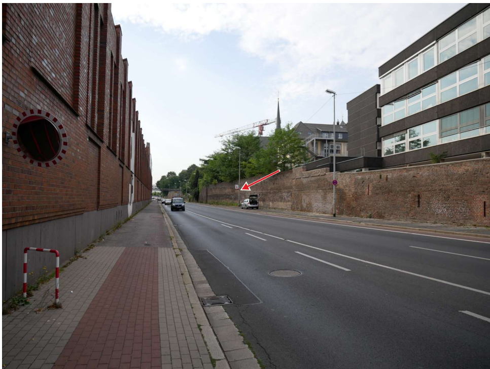
Abbildung 11: Zusätzliche Ansicht - Neuss Batteriestraße (Juli 2018)
