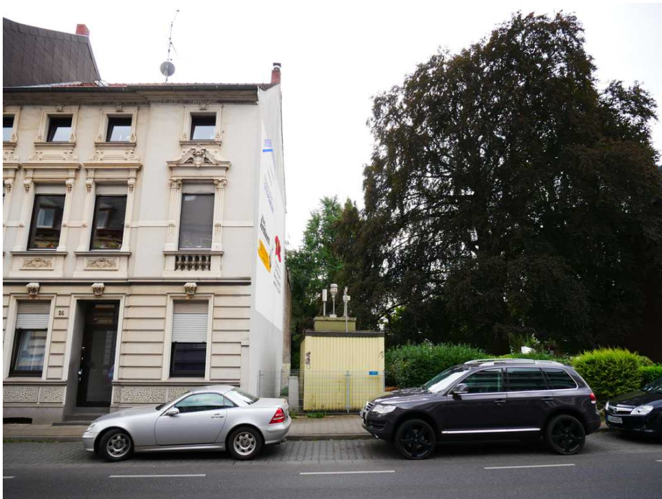
Abbildung 14: Zusätzliche Ansicht - Mönchengladbach Düsseldorfer Straße (August 2018)
