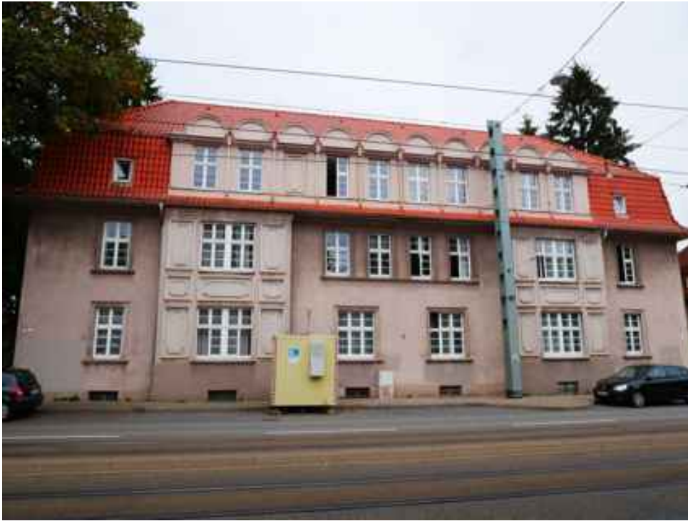
Abbildung 16: Zusätzliche Ansicht - Bielefeld Detmolder Straße (August 2018)
