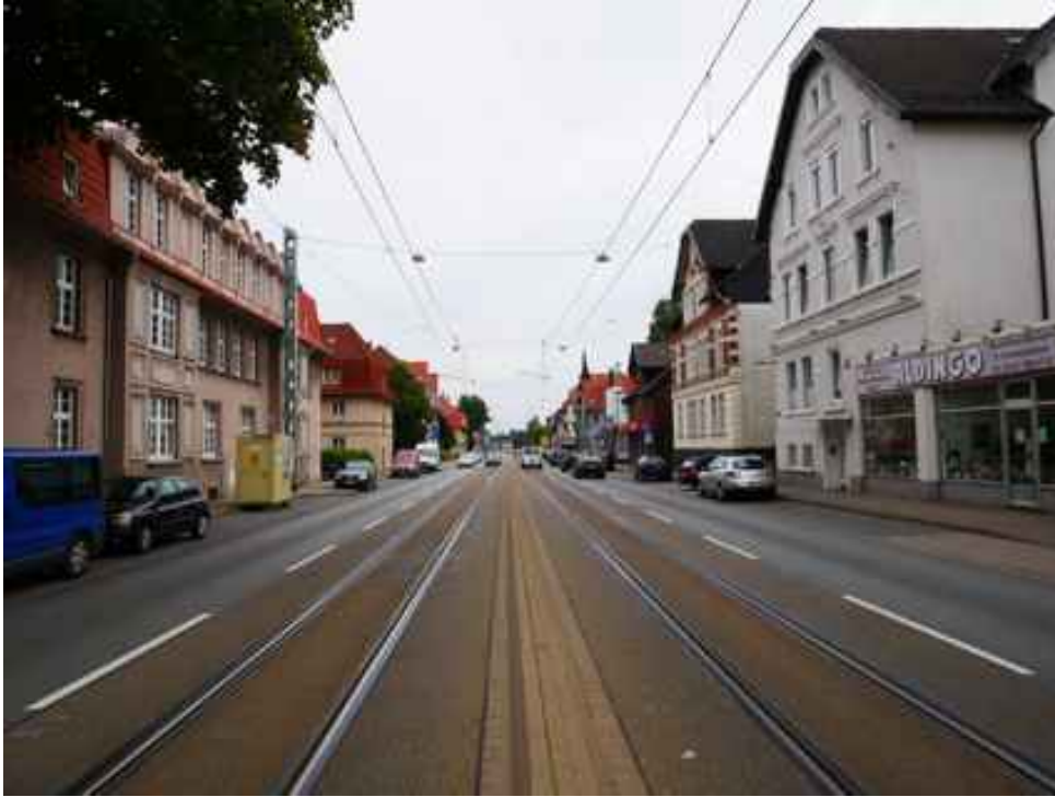
Abbildung 14: Zusätzliche Ansicht - Bielefeld Detmolder Straße (August 2018)
