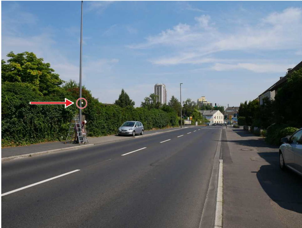
Abbildung 10: Zusätzliche Ansicht - Köln-Meschenich Brühler Landstraße (Juli 2018)
