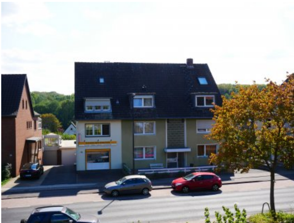
Abbildung 7: Blickrichtung Süden (September 2018)
