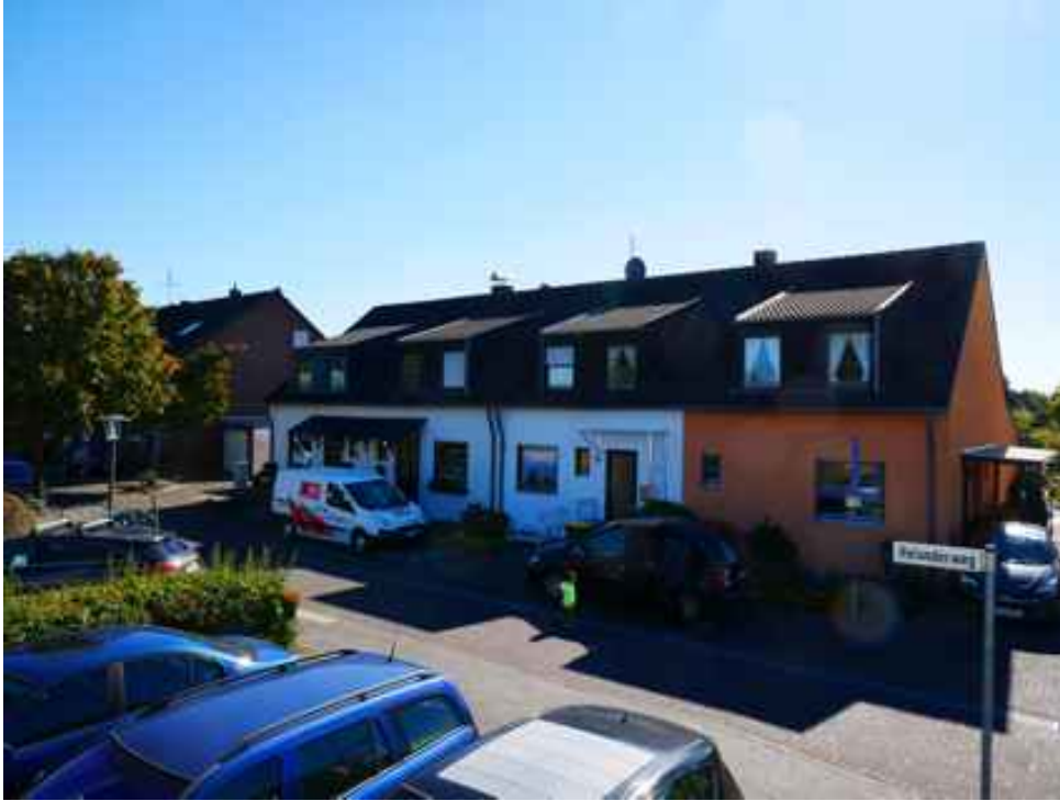
Abbildung 6: Blickrichtung Osten (September 2018)
