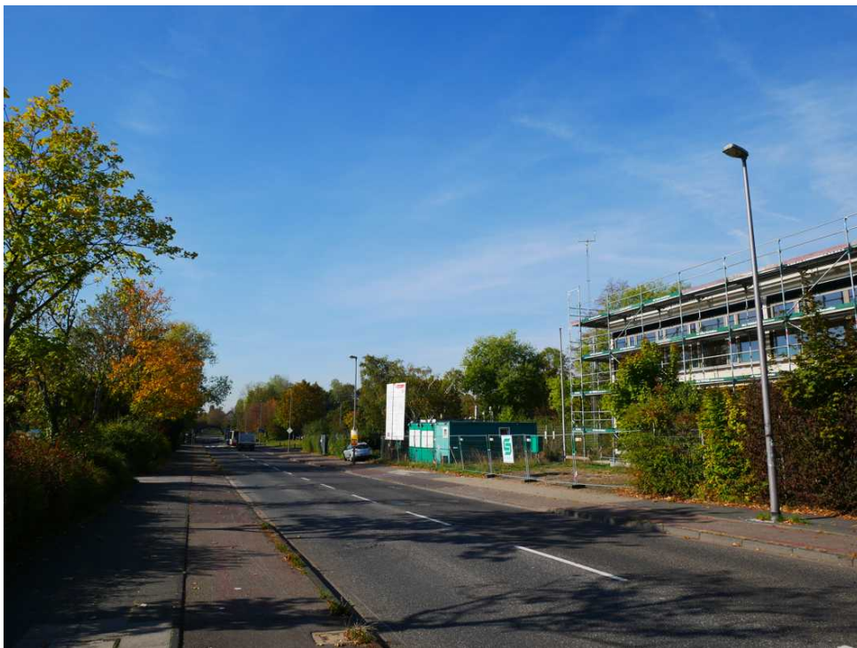
Abbildung 13: Zusätzliche Ansicht - Köln-Chorweiler (Oktober 2018)
