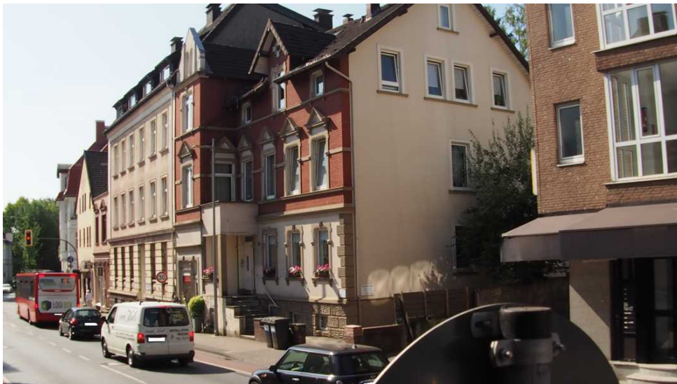
Abbildung 7: Blickrichtung Süden (August 2018)
