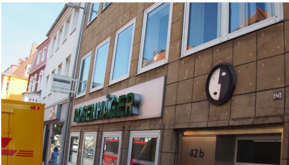
Abbildung 5: Blickrichtung Norden (August 2018)
