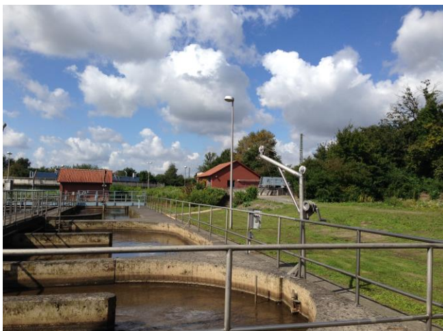
Quelle: aqua consult Ingenieur GmbH
