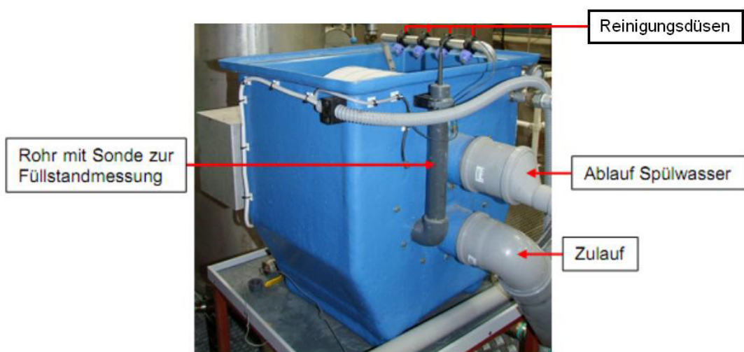
Abbildung 5.24: Funktionsweise des Mikrosiebs (Pinnekamp, 2012)
