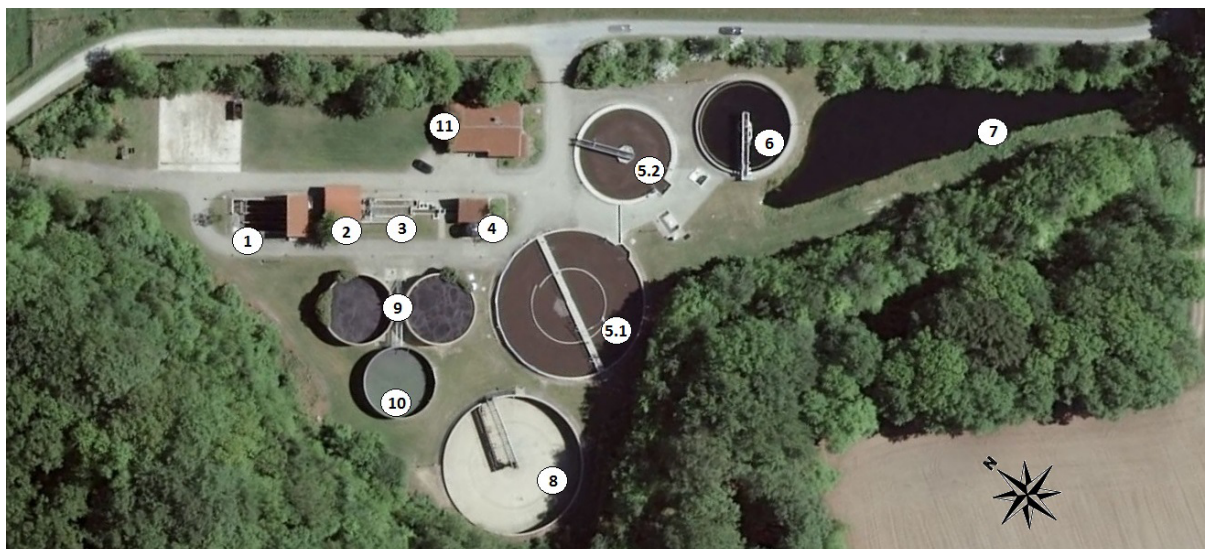
Abbildung 3.1: Luftbild der Kläranlage Saerbeck (verändert und ergänzt nach ELWAS-WEB, 2015)
