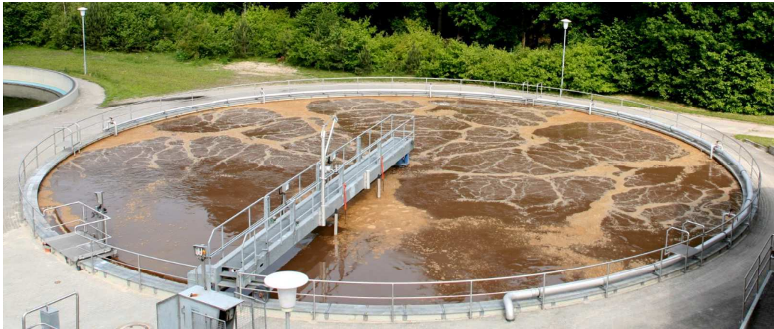
Abb. 1.3.1: Belebungsbecken 1 (BB1), Kläranlage Augustdorf, 2013
