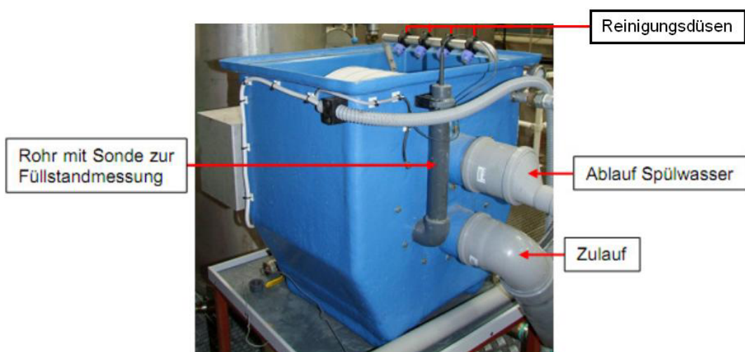
Abbildung 5.24: Funktionsweise des Mikrosiebs (Pinnekamp, 2012)
