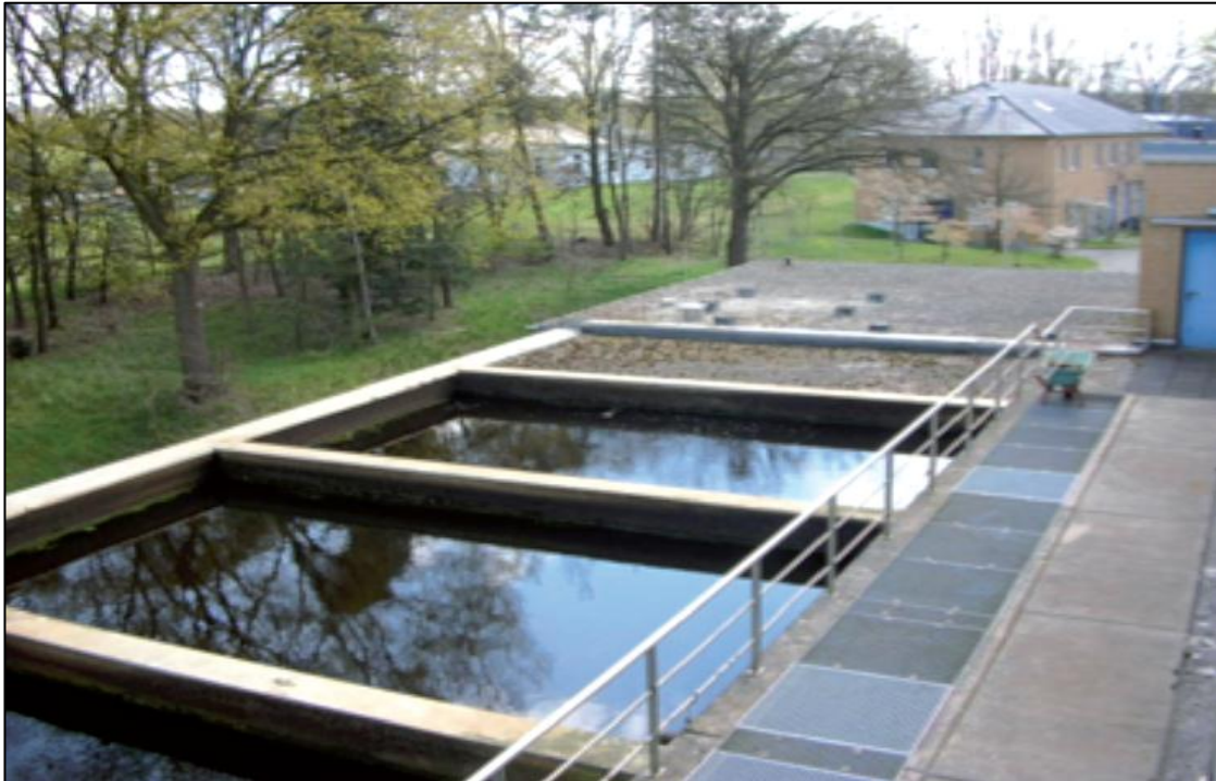
Abb. 3.11: Schwerkraftfilter mit GAK, Kläranlage Gütersloh Putzhagen (MKULNV NRW, 2013)
