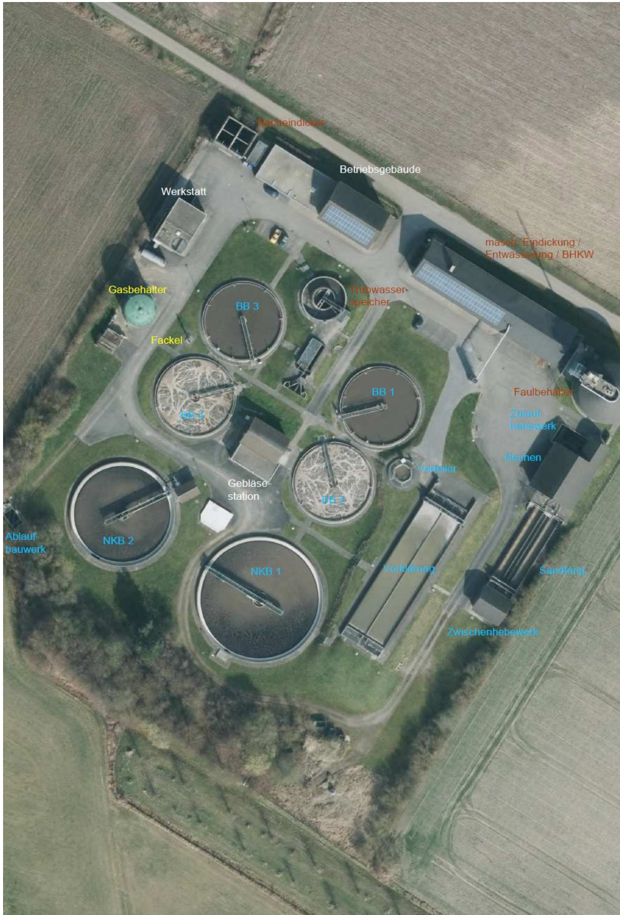
Bild 2.7: Satellitenbild der Kläranlage Salzotten-Verne (Quelle: Geobasisdaten der Kommunen und des Landes NRW)
