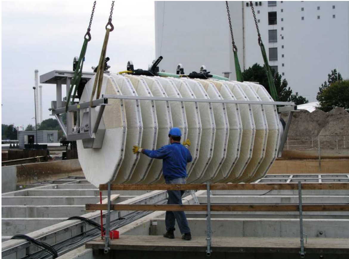
Bild 6-3: Montage eines Scheibenfilters mit 60 \text{ m}^2 (12 Scheiben à 5 \text{ m}^2 ) (Firmenschrift Mecana)
