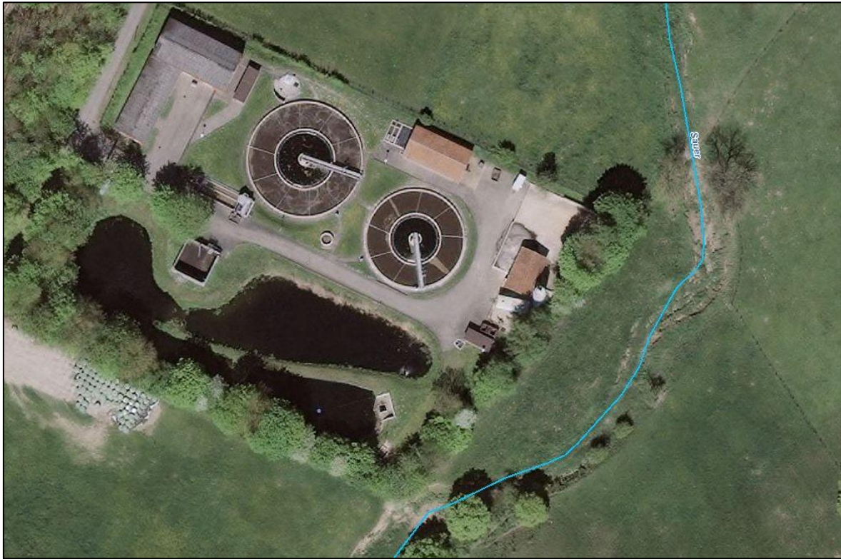
Abb. 2.1: Luftbild der Kläranlage Grundsteinheim ( www.elwasweb.nrw.de )
