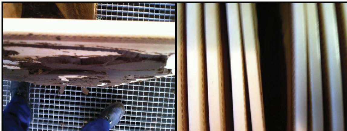
Bild 2-8: Verblockte Membranplatten - Zwischenräume komplett mit Biomasse zugesetzt
