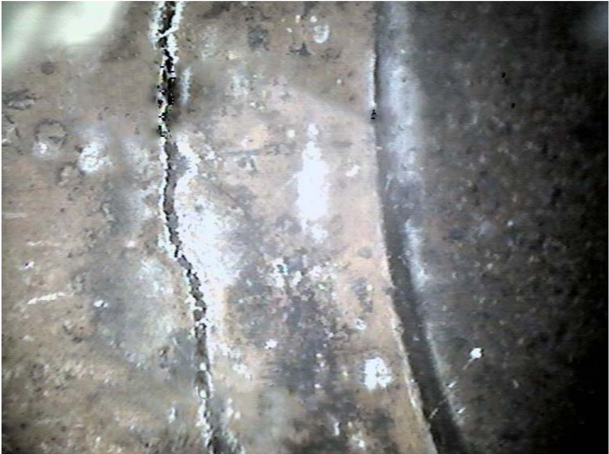
Bild 73: Brandriss im Steinzeugrohr im Bereich vor der Rohrverbindung
