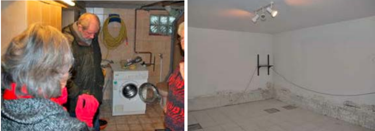
Bild 61: Begleitung der Sanierungsberatung vor Ort, Beratung auf dem Grundstück zum Thema Rückstau (links: Bestandsaufnahme Rückstausicherung, rechts: Feuchtigkeitsschäden im Keller)
