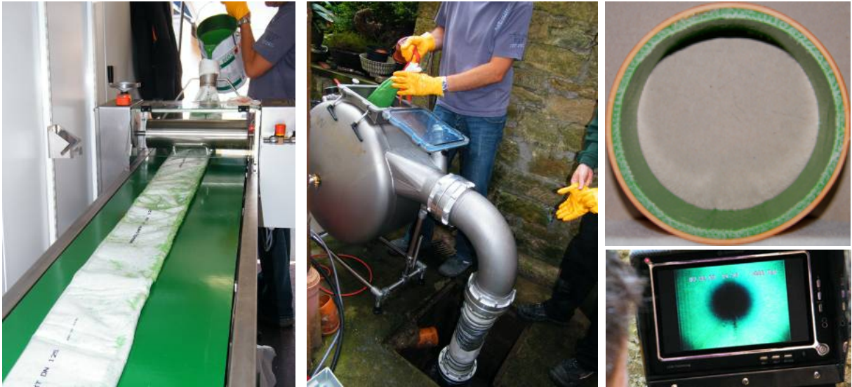
Bild 39: Renovierung durch Schlauchlining in geschlossener Bauweise, Beispielbilder
