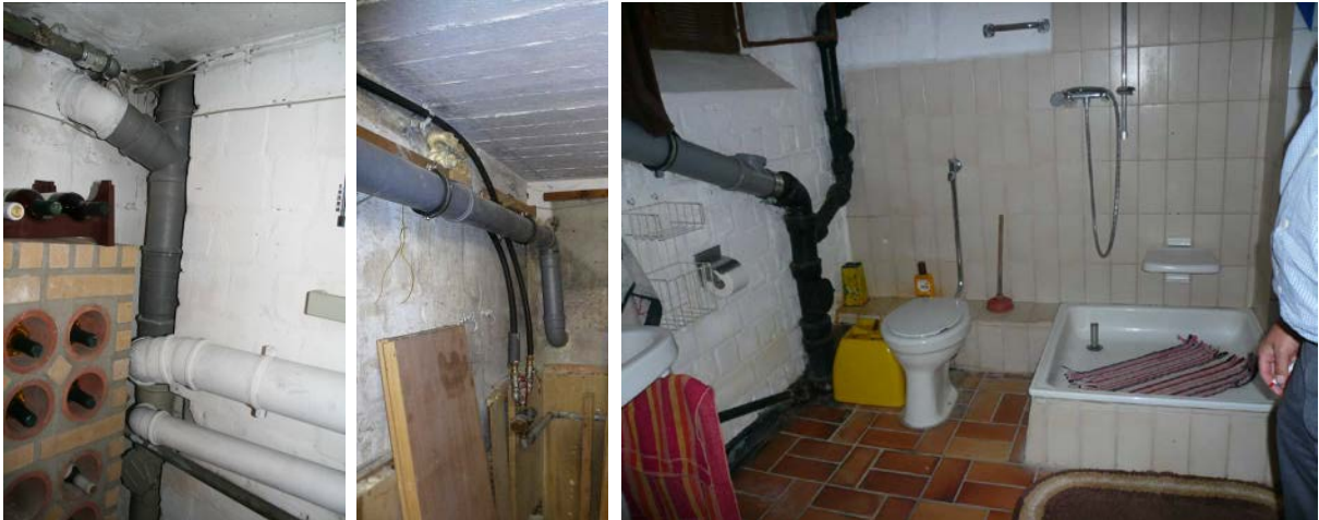
Bild 36: Erneuerung durch Installation von Rohren an Decken und Wänden, Beispielbilder
