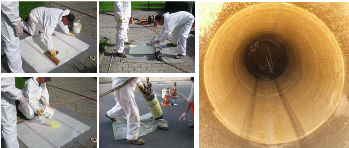
Bild 42: Reparatur durch Kurzliner in geschlossener Bauweise, Beispielbilder
