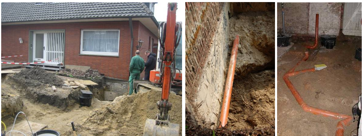
Bild 34: Erneuerung in offener Bauweise, Beispielbilder
