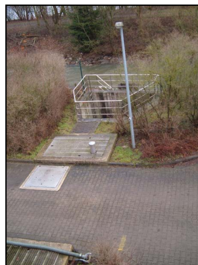
Abbildung 4: Mengenschacht und Auslaufbauwerk Zentralkläwerk Lage (rechts)
