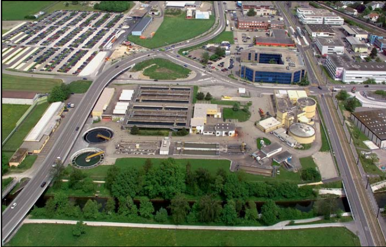
Abbildung 18: Anwendung der Pulveraktivkohle - Versuche auf der Kläranlage Kloten - Schweiz / Luftbild
