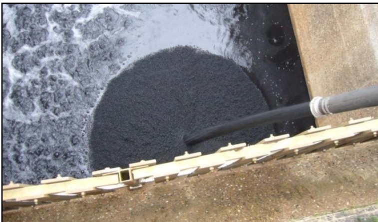
Abbildung 19: Verbandsklärwerk Obere Lutter - Füllung der Filterzelle mit granulierter Aktivkohle
