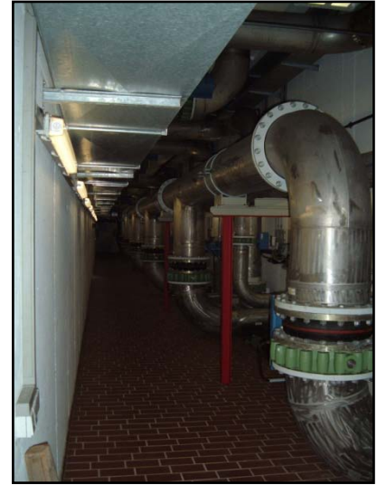
Abbildung 5: FHM-Dosierstation Flockungsfiltration Zentralklärwerk Lage (links)
