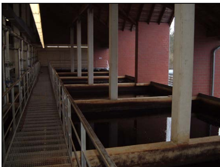
Abbildung 3: Flockungsfiltration Zentralkläwerk Lage (links)
