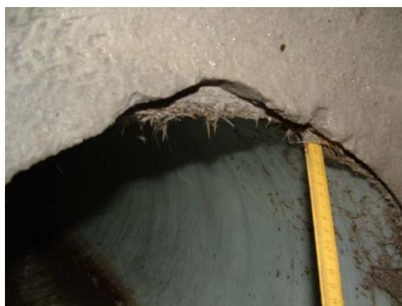
Bild 73 Bündige Anbindung des Schlauchliners mit einem Zementmörtel (links) und unvollständig eingebundener Liner mittels Mörtelbeschichtung (rechts)
