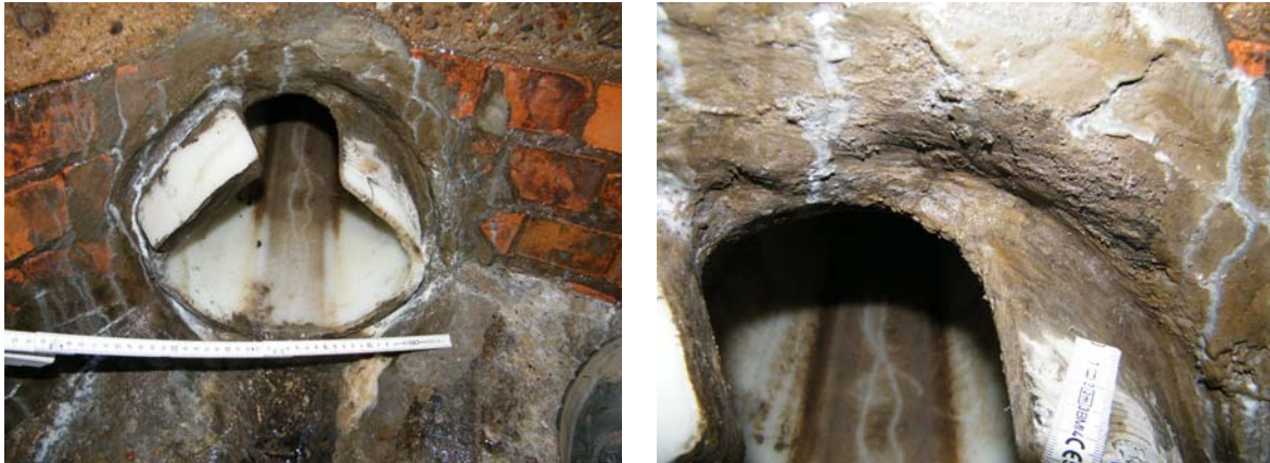
Bild 76 Nachkontrolle des mit Stopfmörtel erfolgreich abgedichteten Ringraums eines PE-Liners in der Gesamtansicht (links) und im Detail am Liner-Scheitel (rechts)
