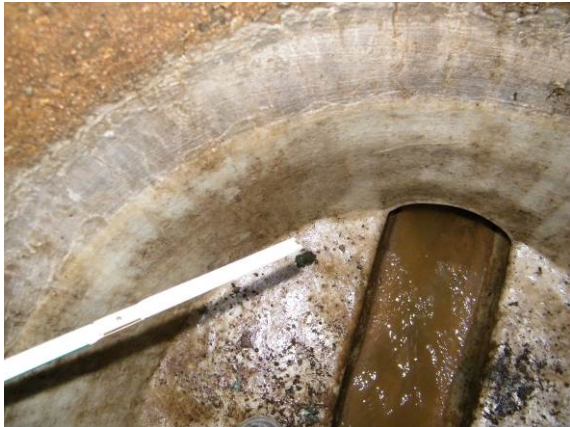
Bild 69 Inspektion der Auskleidung und Lineranbindung bei Bauabnahme (links), eindringendes Grundwasser (roter Pfeil, rechts) nach Haftzugprüfung
