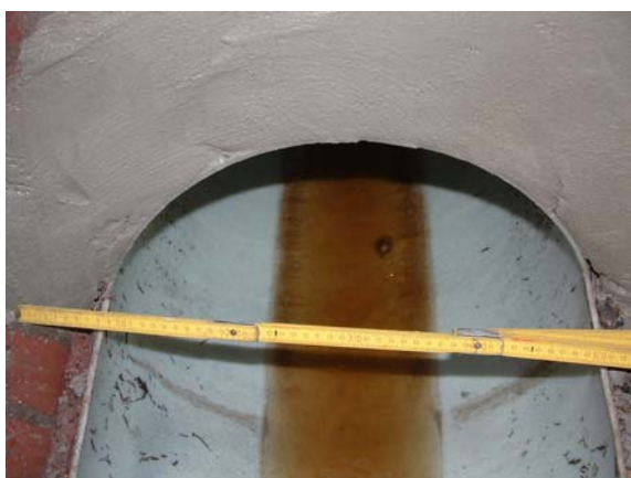
Bild 73 Bündige Anbindung des Schlauchliners mit einem Zementmörtel (links) und unvollständig eingebundener Liner mittels Mörtelbeschichtung (rechts)
