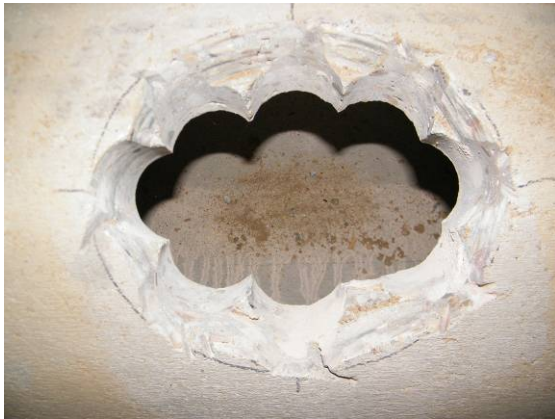
Bild 8 Lochkranz aus acht einzelnen Kernbohrungen (links) und Kernbohrmaschine (rechts)
