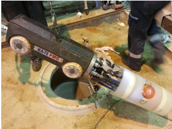
Bild 41 Roboter mit Absperrlement und Schalungsmanschette (links) sowie Vorratsbehälter mit weiteren Absperrlementen (rechts)
