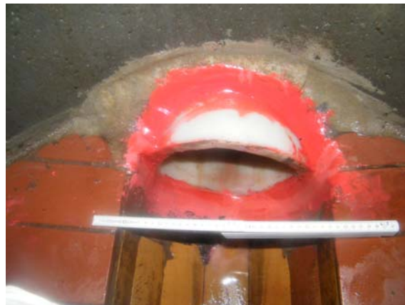
Bild 83 Anbinden des PE-Liners an den Schacht mit Harz 8 durch den Materialhersteller (links); optisches Erscheinungsbild der Anbindung unmittelbar nach Fertigstellung (rechts)
