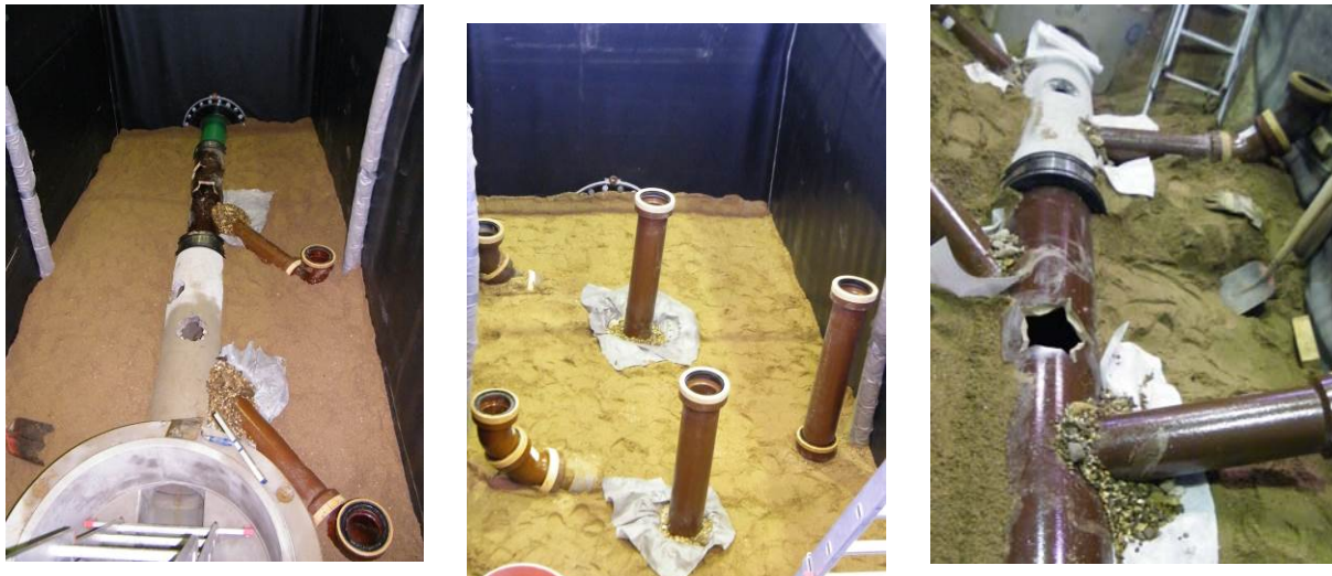
Bild 28 Einbau der Hausanschlussleitungen mit Schaden 1 (links), 2 (mittig) und 3 (rechts)
