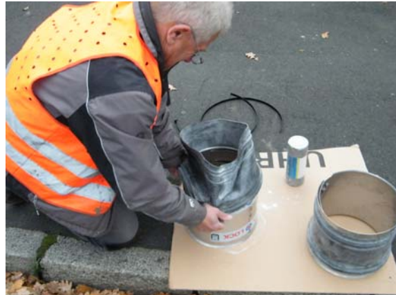
Bild 90 Für einen Manschetten-Einsatz vorbereiteter Bereich mit etwa 14 Zentimeter zurückgeschnittenem Nadelfilzliner (links); Vorbereitung der Spannhülse und Einreiben der Gummi-Manschetten mit Talkum (rechts)
