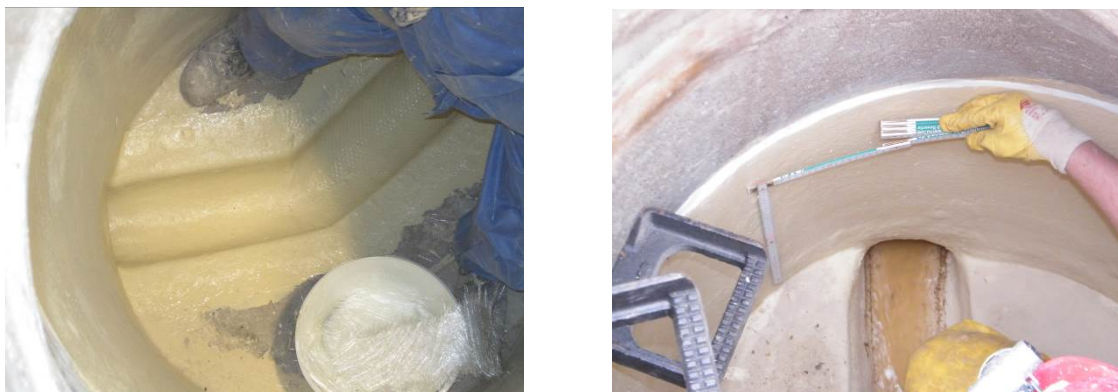
Bild 67 Laminieren der Berme (links) und Kontrolle der Auskleidung (rechts)
