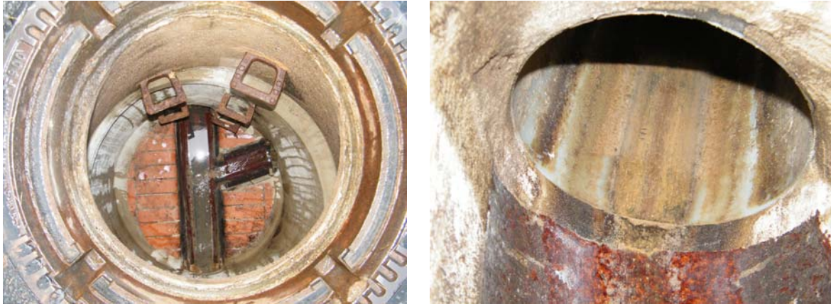
Bild 85 Schacht vor dem Einbau der DEIV-Muffen im Zu- und Ablauf des Hauptgerinnes (links), exemplarische Ansicht eines Anbindebereichs (rechts)
