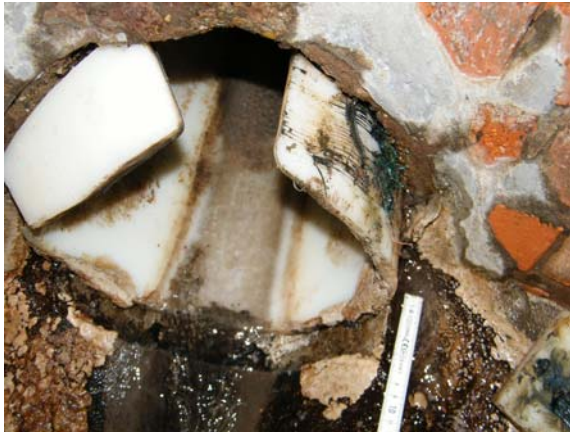
Bild 74 Hervorstehender PE-Liner mit Wassereindrang aus Ringraum (links, siehe Zollstock), Aufstemmen des Ringraums für die Aufnahme einer Stopfmörtel-Packung (rechts)
