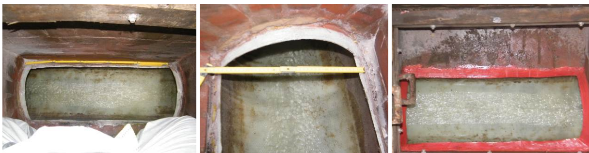
Bild 79 Durchlaufender und geöffneter Liner im Schachtgerinne (links) und Detailaufnahme des Rohranschlussbereichs (mittig); Anbindung der Kontaktflächen des Liners mit den Schacht- und Gerinnewandungen (rechts)
