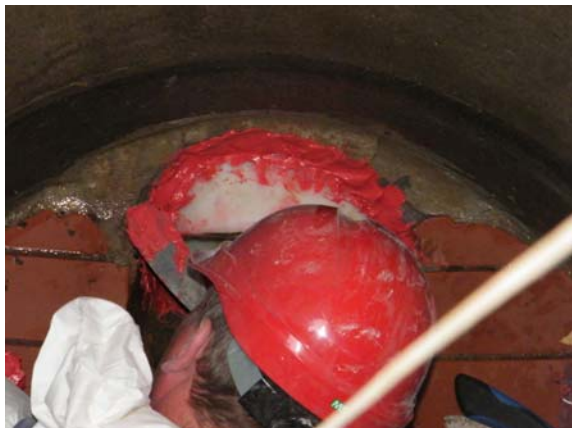
Bild 83 Anbinden des PE-Liners an den Schacht mit Harz 8 durch den Materialhersteller (links); optisches Erscheinungsbild der Anbindung unmittelbar nach Fertigstellung (rechts)
