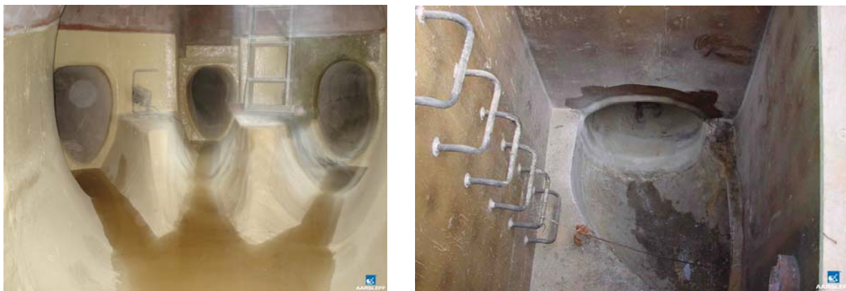
Bild 63 Anschlussanierung mit Handlaminaten der Fa. Aarsleff Rohrsanierung GmbH [28]
