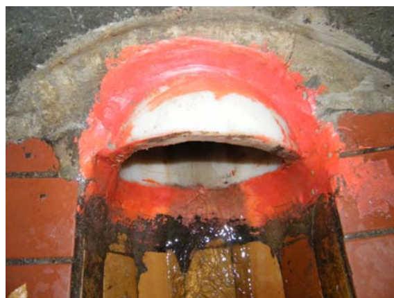
Bild 84 Kontrolle der Anbindung des PE-Liners nach vier Tagen, Ansicht im Schacht (links) und im Detail (rechts)
