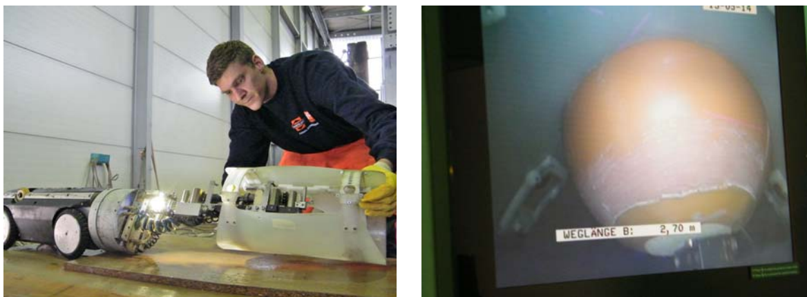
Bild 57 Roboter wird mit Schalungsmanschette bestückt (links) und aufgepumptes Absperrelement als Verschluss der Manschettöffnung und des Hausanschlusses (rechts)
