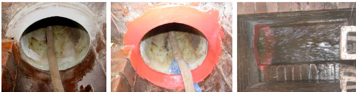
Bild 77 Gesäubertes Anschlussbereich mit entgratetem Liner vor der Verspachtelung mit Harz 8 (links), vollständig verspachtelter Anschlussbereich während der Aushärtezeit (mittig) und nach ca. einer Stunde Aushärtezeit mit Wasserbelastung (rechts)
