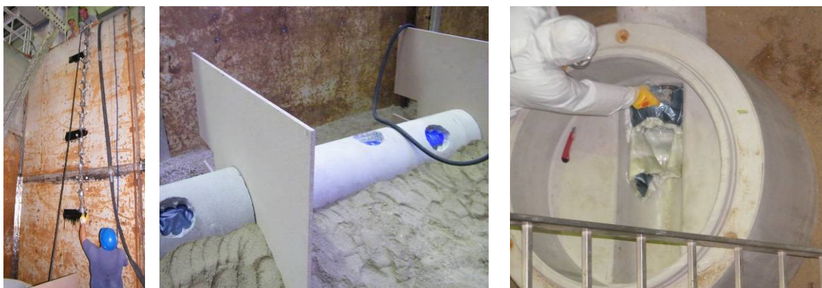
Bild 13 Herablassen der UV-Lampenkette in den Großversuchsstand (links), Durchfahren des Rohrstrangs mit der Lampenkette (mittig) und Entfernen von Reststücken aus dem Schachtgerinne (rechts)
