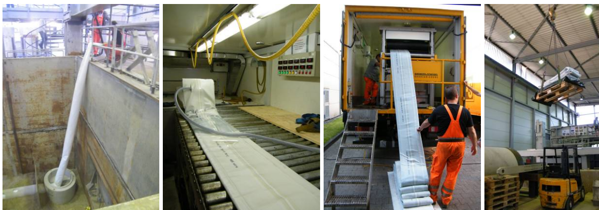
Bild 14 Einziehen des Preliners in die Halterung, Tränken des Nadelfilzschlauchs mit Epoxidharz, Zusammenlegen und Verfrachten des getränkten Nadelfilzschlauchs zum Großversuchsstand (von links nach rechts)
