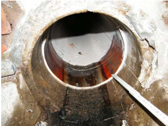
Bild 90 Für einen Manschetten-Einsatz vorbereiteter Bereich mit etwa 14 Zentimeter zurückgeschnittenem Nadelfilzliner (links); Vorbereitung der Spannhülse und Einreiben der Gummi-Manschetten mit Talkum (rechts)
