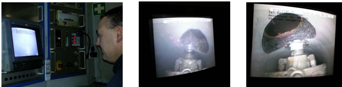
Bild 39 Monitor zur Beobachtung der Fräsarbeiten (links), rotierender Einlaufräser (mittig) und Tellerfräser zur Herstellung einer umlaufenden Nut (rechts)
