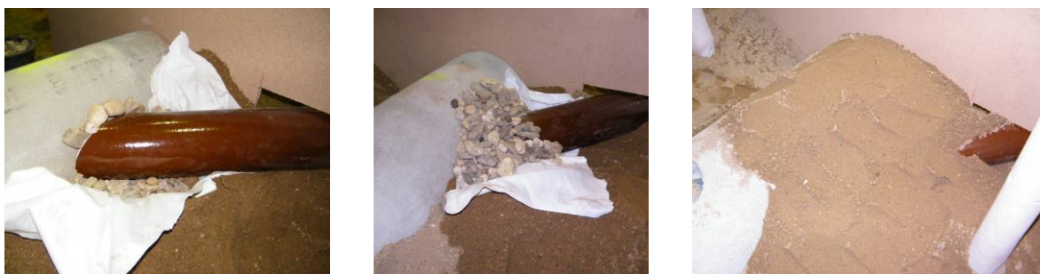
Bild 18 Schadensbild 1: Anlegen des vorbereiteten Steinzeugrohrs auf Vlies und Kies (links), Auffüllen der Kiespackung (mittig) und Überschütten des Rohranschlussbereichs mit Kies-Sand (rechts)
