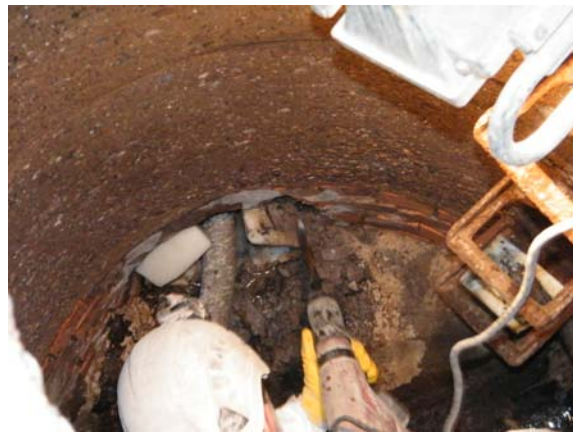
Bild 74 Hervorstehender PE-Liner mit Wassereindrang aus Ringraum (links, siehe Zollstock), Aufstemmen des Ringraums für die Aufnahme einer Stopfmörtel-Packung (rechts)
