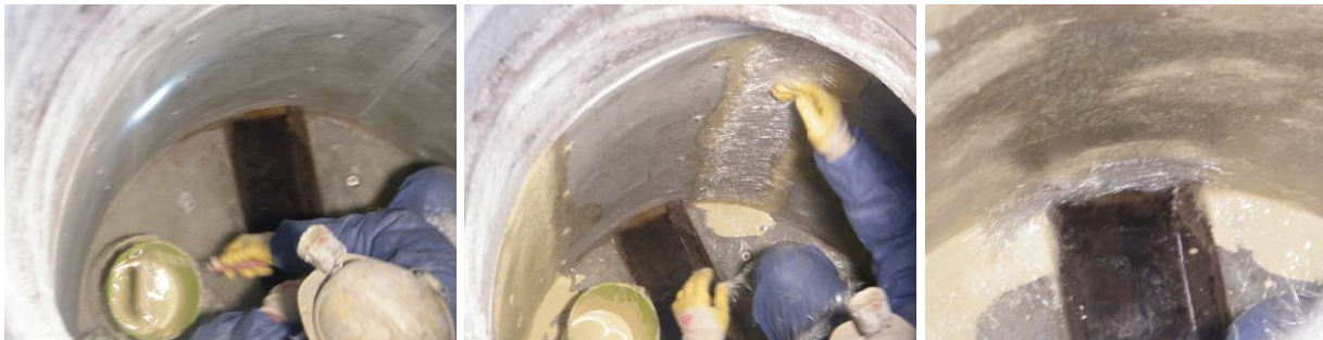
Bild 66 Mit angeschraubten GFK-Platten versehener Schacht (links) und Bestreichen der Platten und des Gewebes mit Harz (mittig); Teilansicht der GFK-Auskleidung mit bereits überlamierten Schraubenköpfen und Stoßfugen (rechts)
