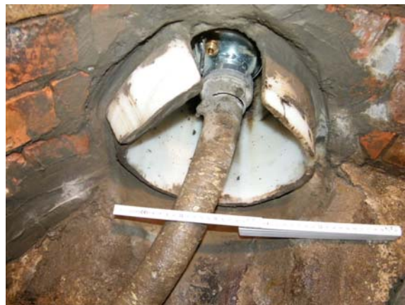
Bild 75 Anbindung des PE-Liners mit einem schnell abbindendem Stopfmörtel (links) und abgedichteter Ringraum des PE-Liners (rechts)
