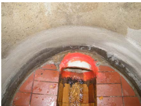
Bild 84 Kontrolle der Anbindung des PE-Liners nach vier Tagen, Ansicht im Schacht (links) und im Detail (rechts)
