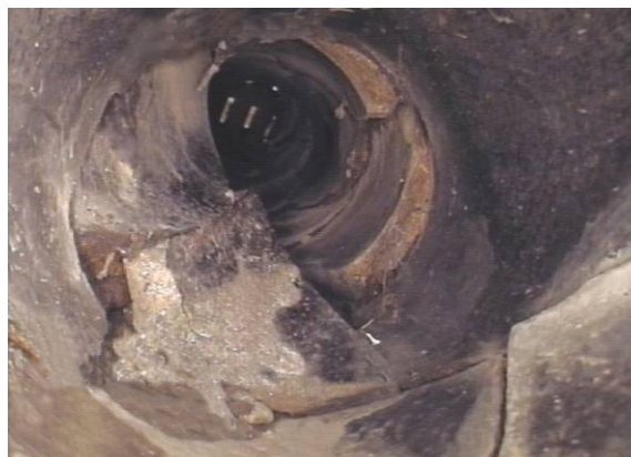
Bild 2 Reparaturverfahren möglich bei schadhafter Muffenverbindung (links) bzw. nicht möglich bei ausgedehnter Scherbenbildung (rechts)
