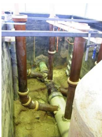
Bild 35 Freigelegte Haltung (links), Begrenzung des Prüfraumes im Hauptkanal durch Absperrblasen (rechts)
