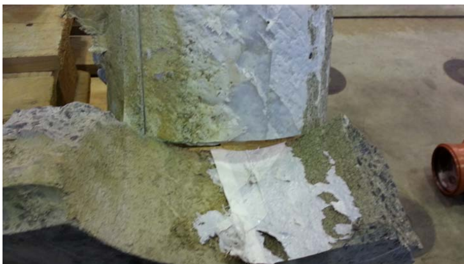
Bild 118 Preliner und davon getrenntes Altrohrstück, Preliner lokal eingerissen und Harz mit Altrohr verklebt
