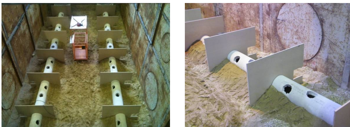
Bild 11 Für den Linereinbau vorbereitete (links) und in Kies-Sand gebettete Rohrstränge bzw. -stücke (rechts)
