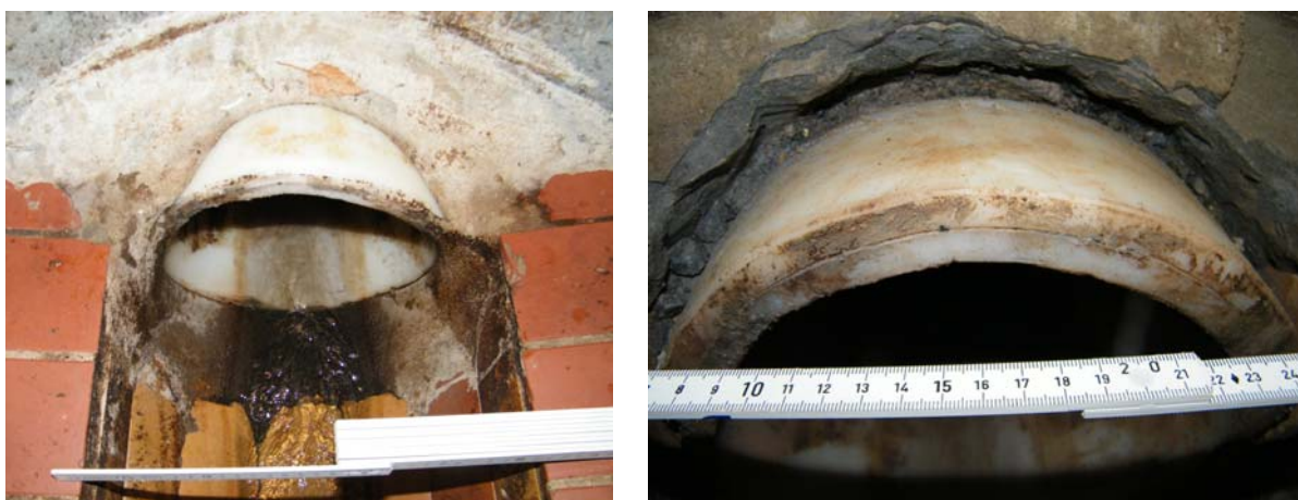
Bild 82 Ausgangs- und Anschlusssituation des mit Mörtel umgebenen PE-Liners (links); weggestemmter Mörtel und hergestellte Ringnut zwischen Mörtel und PE-Liner (rechts)
