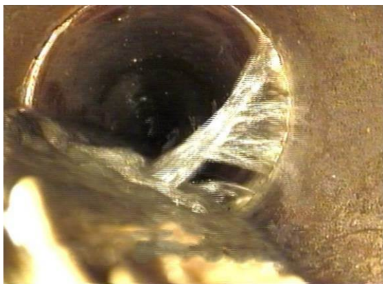
Bild 2 Reparaturverfahren möglich bei schadhafter Muffenverbindung (links) bzw. nicht möglich bei ausgedehnter Scherbenbildung (rechts)
