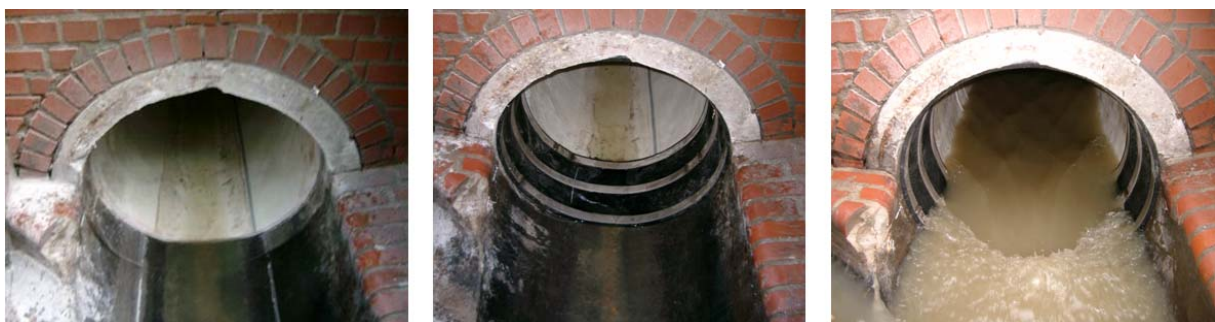
Bild 88 Abwasserfreier Schacht und bereits zurück geschnittener Schlauchliner (links) mit eingesetzter Manschette (mittig) sowie Lineranbindung mittels Manschette in Betrieb (rechts)
