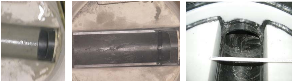
Bild 94 Im Rohranschluss eingesetzte Stüpe (links), mit angeschweißter Gerinnehalbschale (mittig) sowie Auftritten und Übergangsring (rechts)
