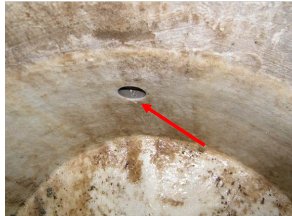
Bild 69 Inspektion der Auskleidung und Lineranbindung bei Bauabnahme (links), eindringendes Grundwasser (roter Pfeil, rechts) nach Haftzugprüfung
