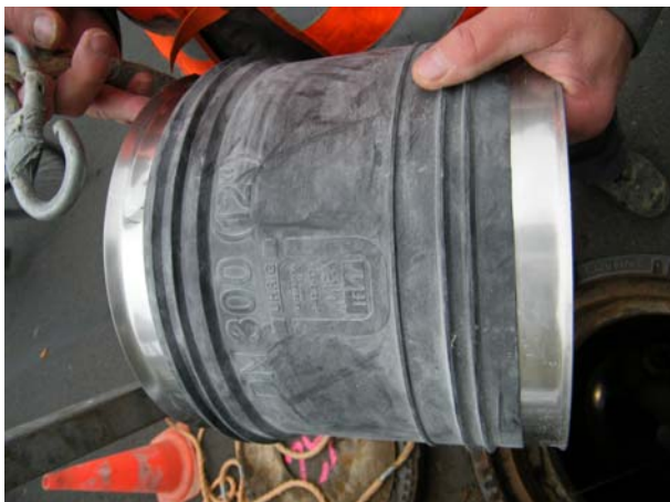
Bild 91 Für den Einbau vorbereitete Manschette (links) und Packer zum Aufstellen der Manschette im Kanal (rechts)
