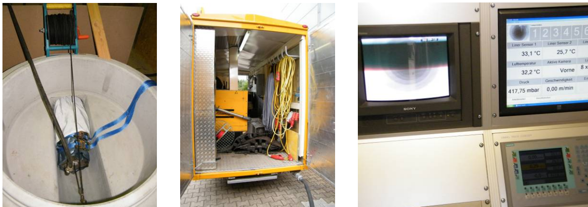
Bild 12 Einziehen des vorkonfektionierten Liners einschließlich Preliner (links) und Aufstellen des Liners mittels Überdruck, erzeugt mittels Kompressor (mittig) und Überwachungsmonitor mit Druckanzeige (rechts)
