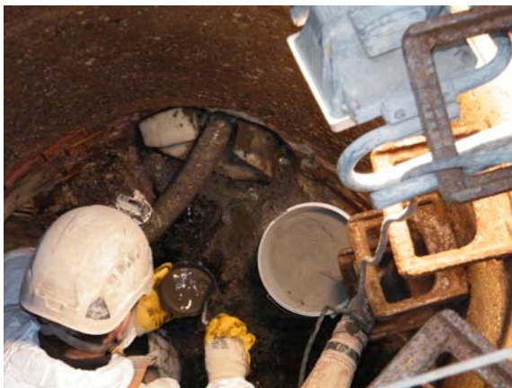
Bild 75 Anbindung des PE-Liners mit einem schnell abbindendem Stopfmörtel (links) und abgedichteter Ringraum des PE-Liners (rechts)
