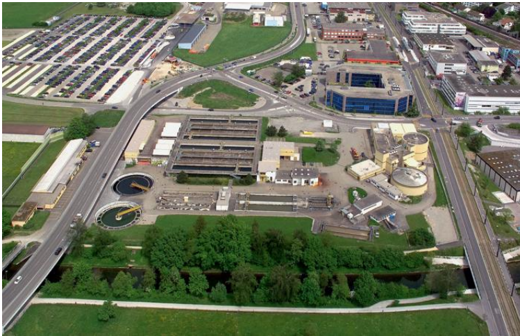
Abbildung 15: Anwendung der Pulveraktivkohle - Versuche auf der Kläranlage Kloten – Schweiz / Luftbild
