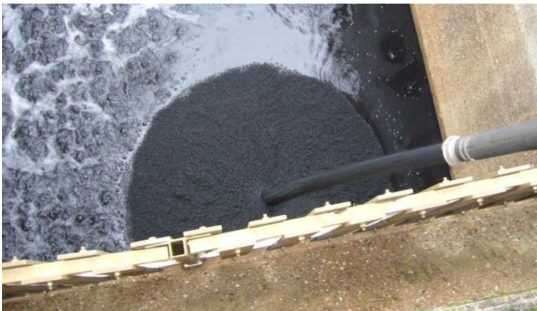
Abbildung 16: Verbandsklärwerk Obere Lutter – Füllung der Filterzelle mit granulierter Aktivkohle
