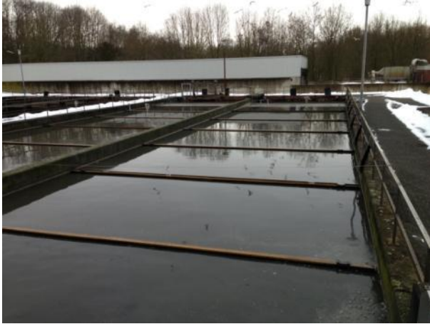
Abbildung 3: A-Stufe Kläranlage Löhne (links)
