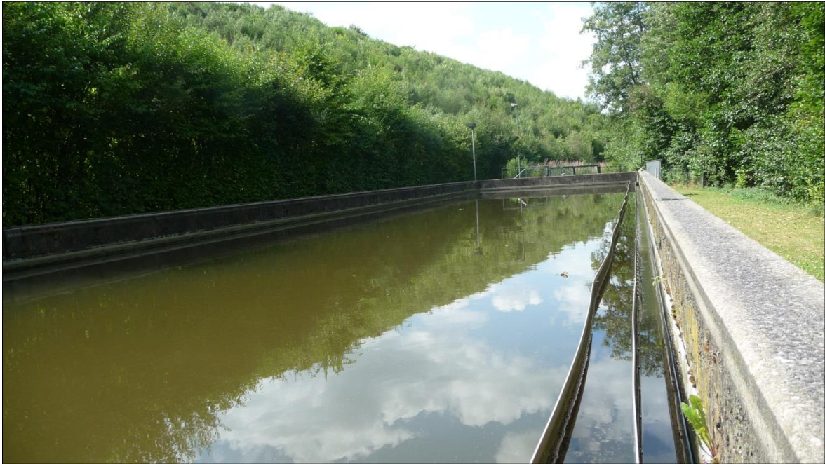
Abb. 20: Nachklärbecken der Kläranlage Netphen
