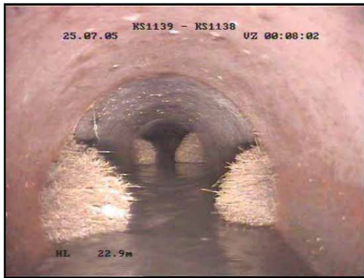
Abbildung 185: Wurzeleinwuchs (Backnang, 2014)
