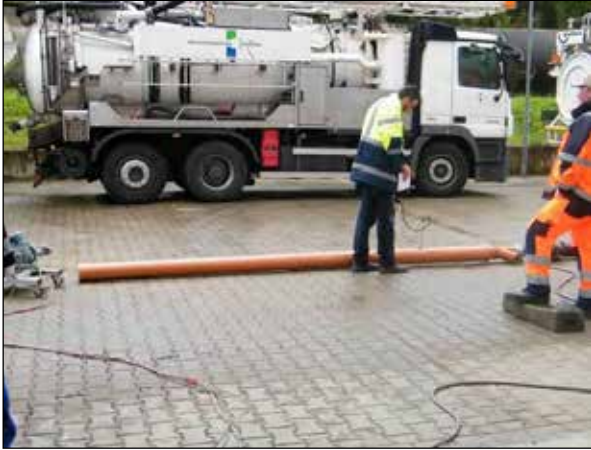
Abbildung 160: Prüfung der Vakuumpumpe, Beruhigungsstrecke 4m
