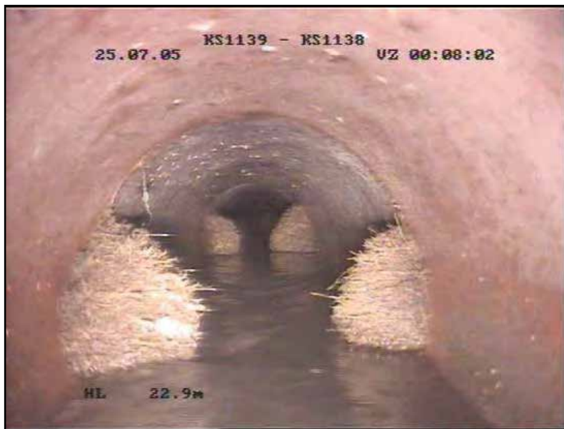
Wurzeleinwuchs [Backnang, 2014]
