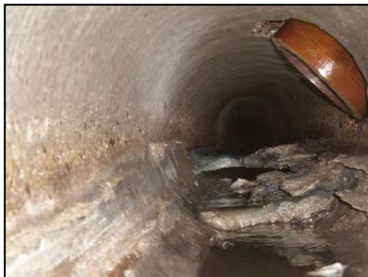
Abbildung 190: Einragende Stützen (Vordereifel, 2014)
