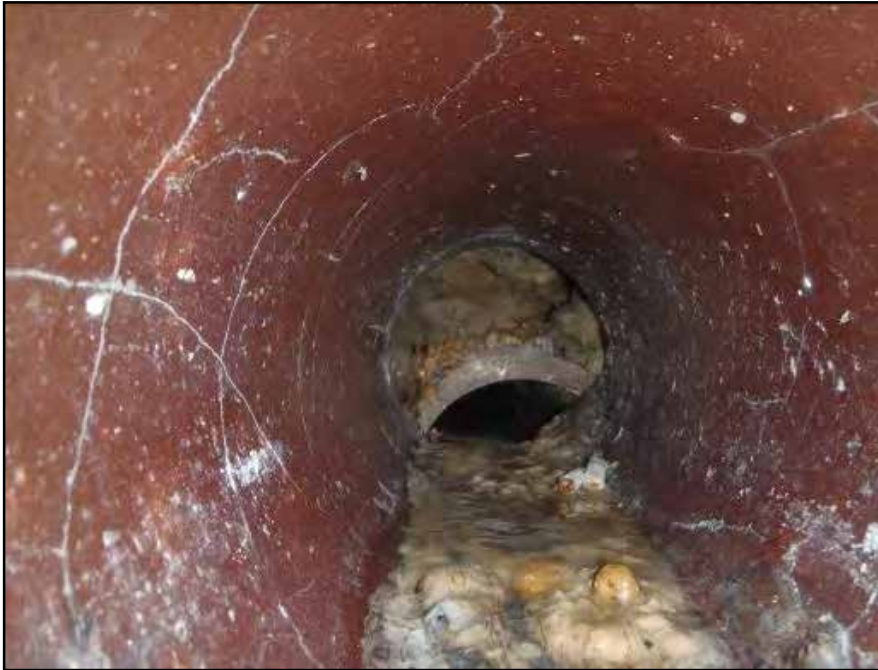
Versackung/ Muffenversatz [Backnang, 2014]
