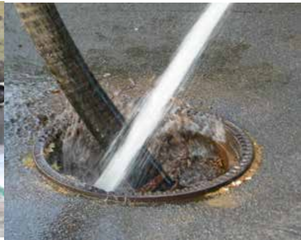
Abbildung 111: Schmutzfängerreinigung mit Freistrahl und Saugschlauch (van Laak, 2014b)
