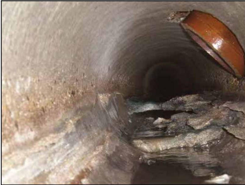
Einragender Stutzen [Vordereifel, 2014]
