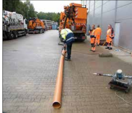
Abbildung 161: Prüfung der Vakuumpumpe, Beruhigungsstrecke 5m
