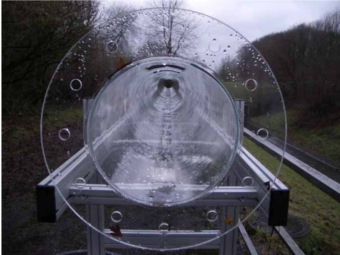
Abbildung 31: Plexiglasrohr während der Montage
