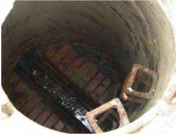
Abbildung 108: Inaugenscheinnahme des Schachtgerinnes (van Laak, 2014a)
