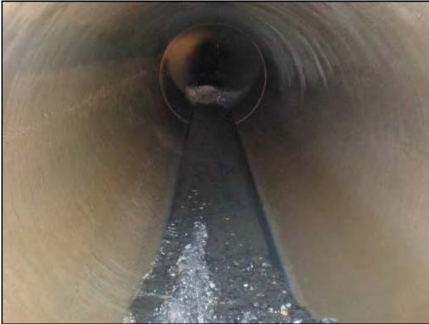
Geringses Sohlgefälle [Vordereifel, 2014]
