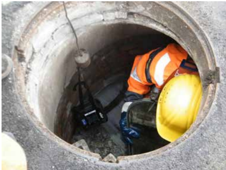
Abbildung 116: Grobe Bewertung des Haltungszustands mit dem Kanalspiegel
