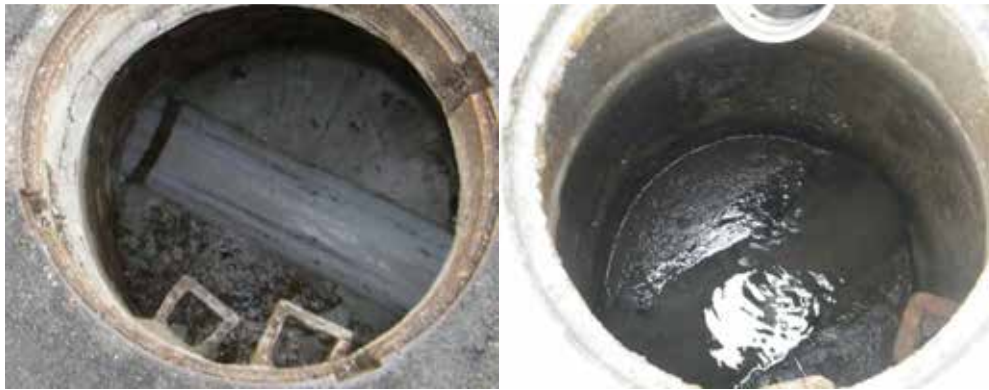
Abbildung 17: Inaugenscheinnahme des Schachtgerinnes (Begleitung der Kanalreinigungsarbeiten der TBV, 2014; Begleitung der Kanalreinigungsarbeiten der Stadt Gladbeck, 2014)
