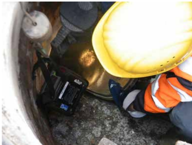
Abbildung 16: Kanalspiegelung mit Lichtquelle am Beobachterschacht
