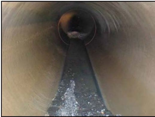
Abbildung 191: Geringes Sohlgefälle (Vordereifel, 2014)
