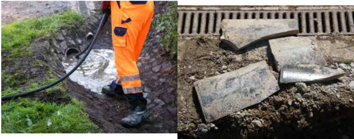
Abbildung 112: Vorstrahlende Düse für Einsatz bei starken Verschmutzungen und Verstopfungen (van Laak, 2014c)
