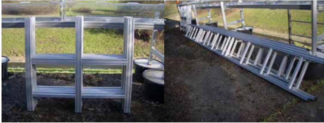
Abbildung 34: Unterkonstruktion für die Versuchsrohre (links: Vertikale Stützen mit höhenverstellbaren Querstreben; rechts: Horizontale Träger als Auflage für die Versuchsrohre)
