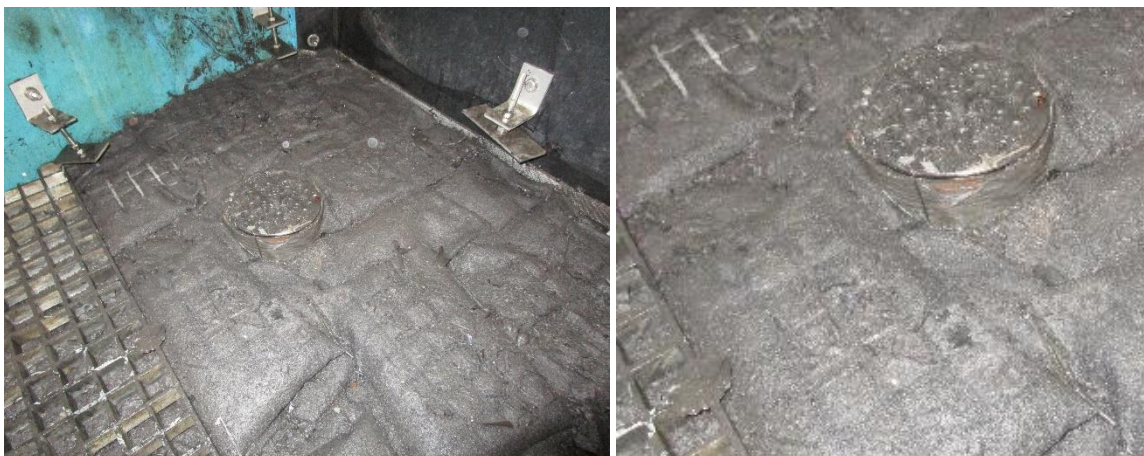
Abbildung 133: Filteroberseite bei Ausbau der Feldsäulen, Standort Mönchengladbach
