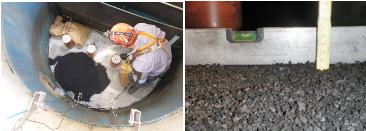
Abbildung 68: Einbau Braunkohlekoks (Ronsdorfer Straße in Wuppertal)
