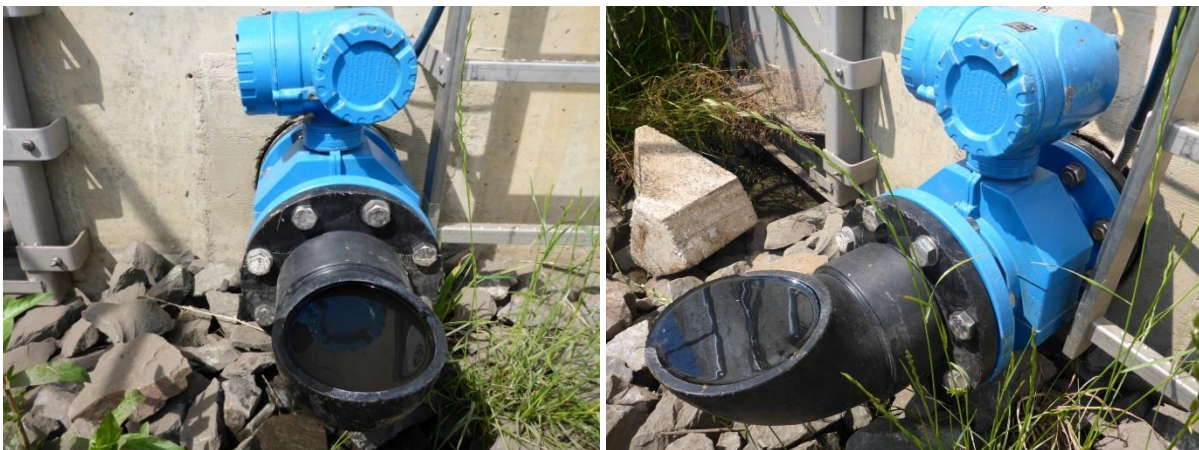
Abbildung 114: Gedückertes MID im Ablauf des Filterschachtes
