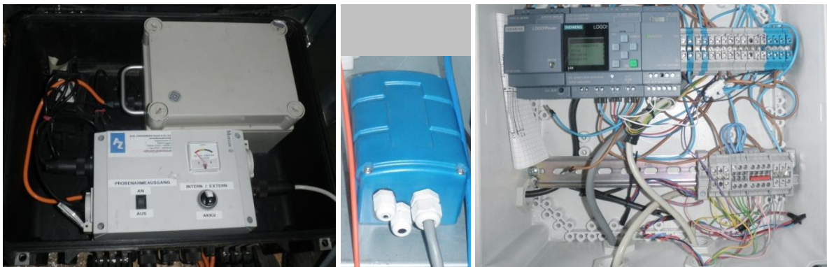
Abbildung 117: FELIX Anschlussbox (Abbildung links), DFÜ für die Übertragung der Durchflusswerte und Steuerbefehle an die SPS (Mitte) und Verschaltung der SPS (Abbildung rechts)
