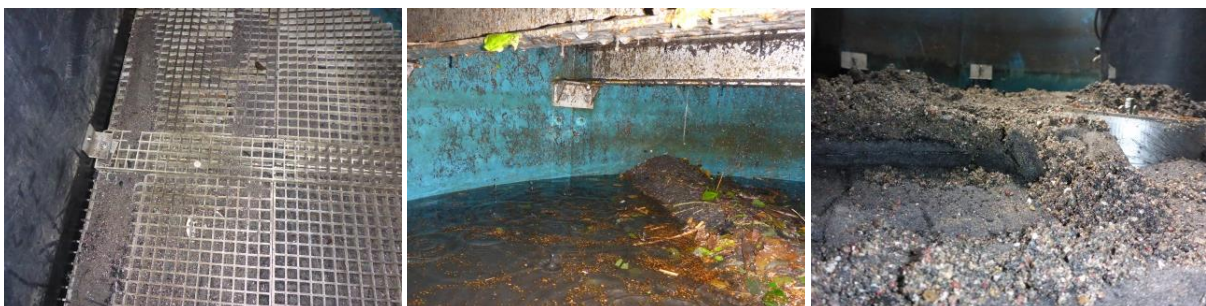
Abbildung 87: Sand auf dem Filter (links), im Sedimentationsraum (Mitte), Detailansicht (rechts)
