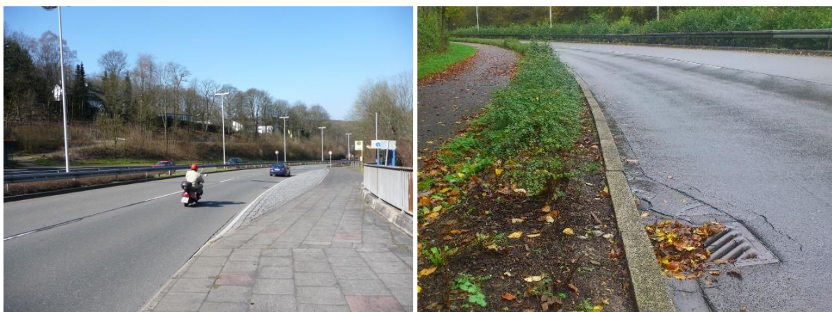
Abbildung 73: Standort Wuppertal, Ronsdorfer Straße
