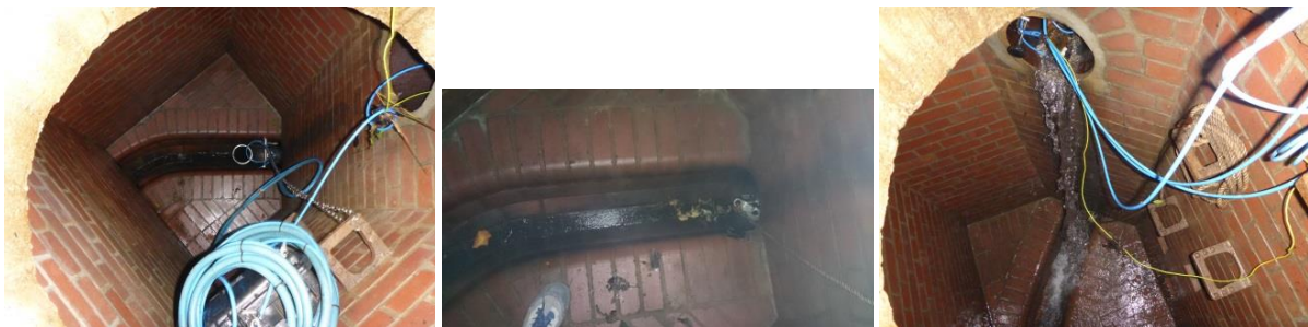
Abbildung 80: Messung in der unteren Leitung (links), verschlossene untere Leitung (Mitte), Messung in der oberen Leitung (rechts)
