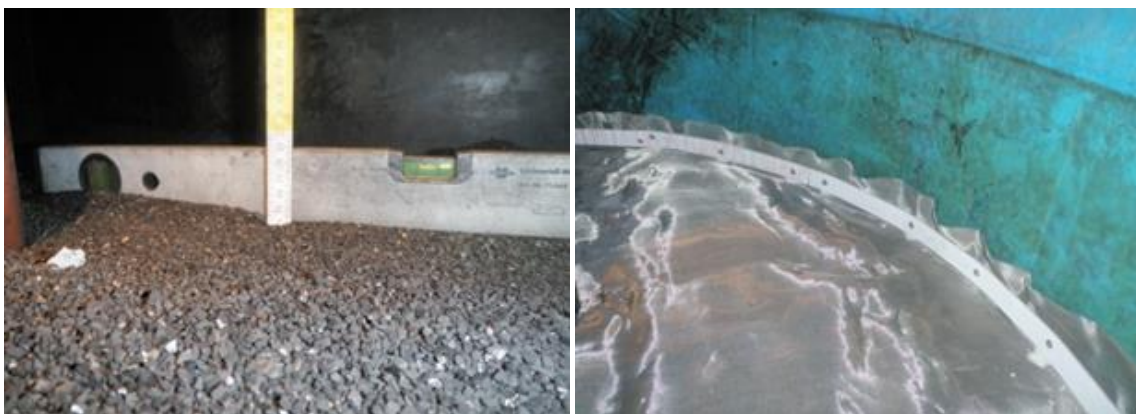
Abbildung 69: Einbau Aktivkohle und abschließendes Edelstahlgeflecht (Ronsdorfer Straße in Wuppertal)
