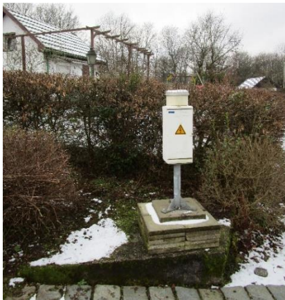
Abbildung 78: Regenschreiber auf dem Gelände der Kleingartenanlage Böhlerfeld
