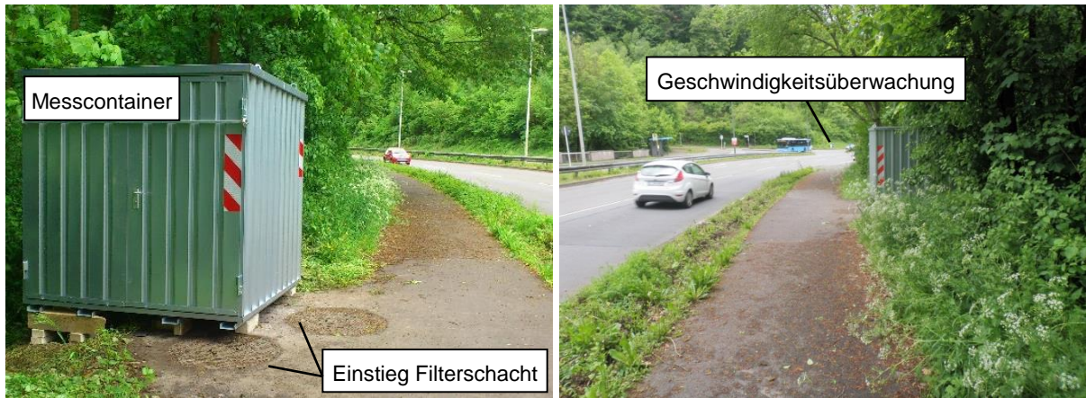
Abbildung 74: Standort Wuppertal, Ronsdorfer Straße
