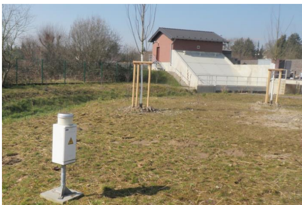
Abbildung 112: Regenschreiberstandort auf dem Gelände des RRB
