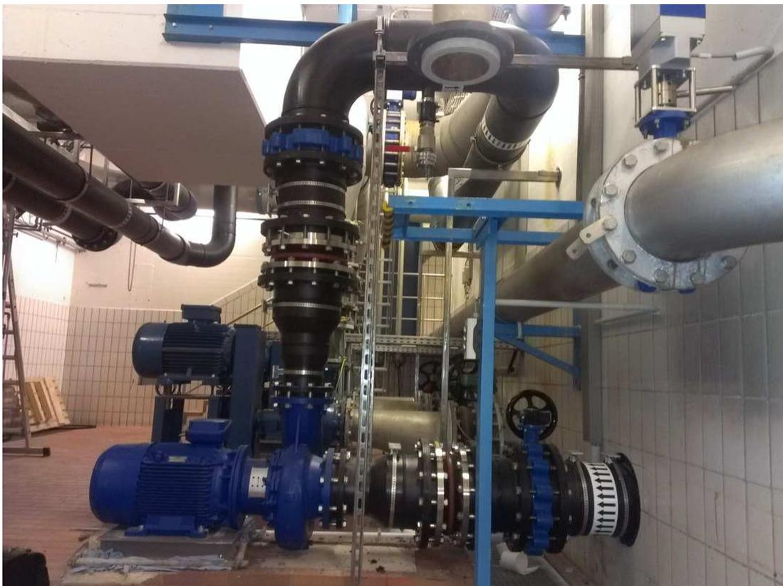
**Abbildung 5:** Aufstellung der neuen Beschickungspumpe
