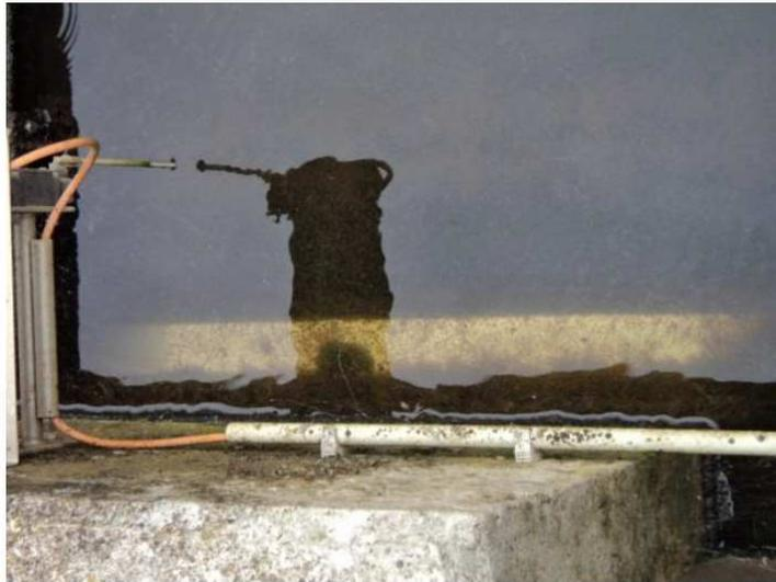
**Abbildung 7:** Schlammflocken am Einlauf der Nachklärung bei hydraulischer Niedriglast
