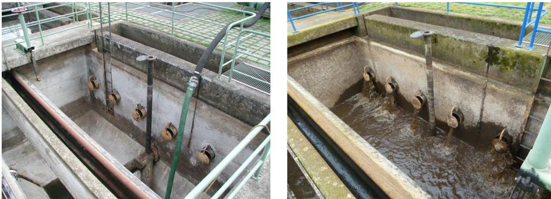
**Abbildung 9:** Stengeleinläufe im Zulauf der Nachklärung
