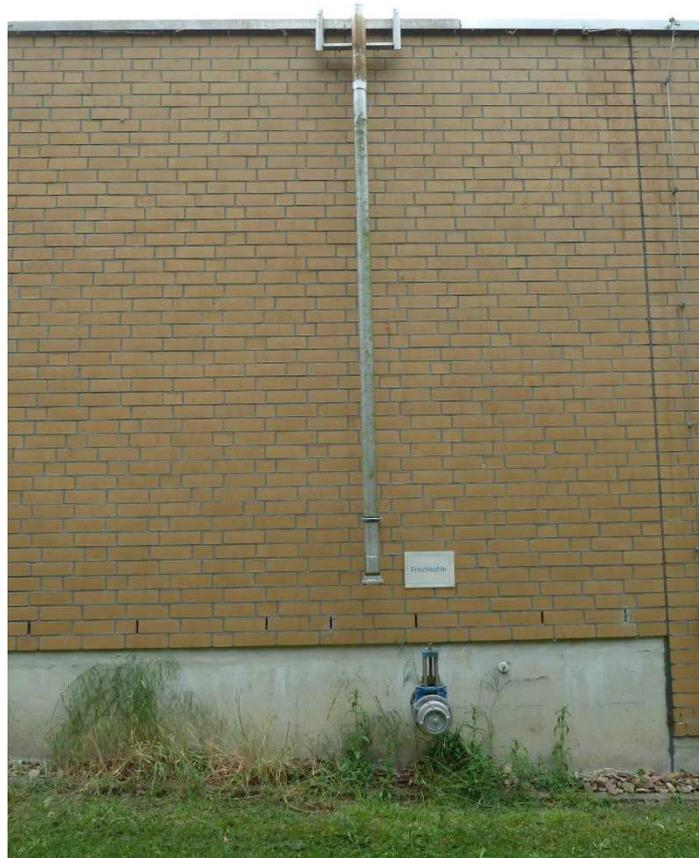
**Abbildung 33:** GAK-Befüllleitung der Aktivkohlefilter bzw. Adsorber (Mitte bis oben) und GAK- Austragsstutzen (unten)
