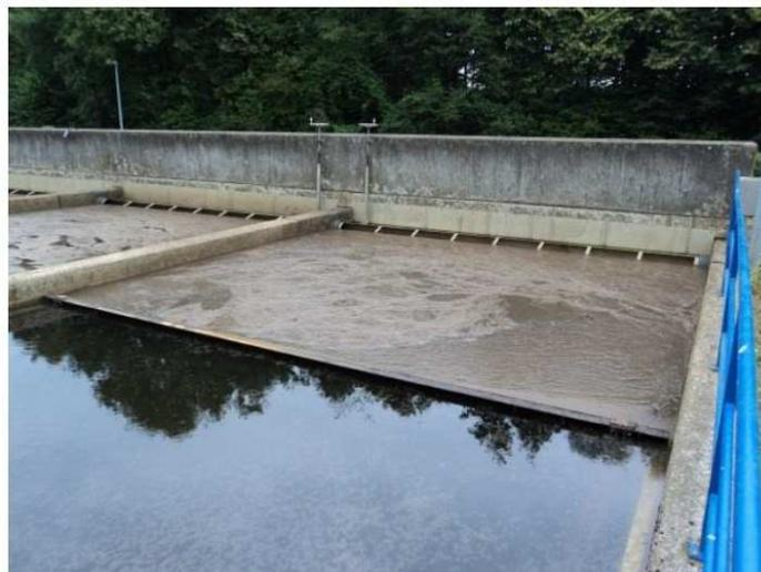
**Abbildung 8:** Schwimmschlamm im Ablaufbereich der Nachklärung bei hydraulischer Niedriglast
