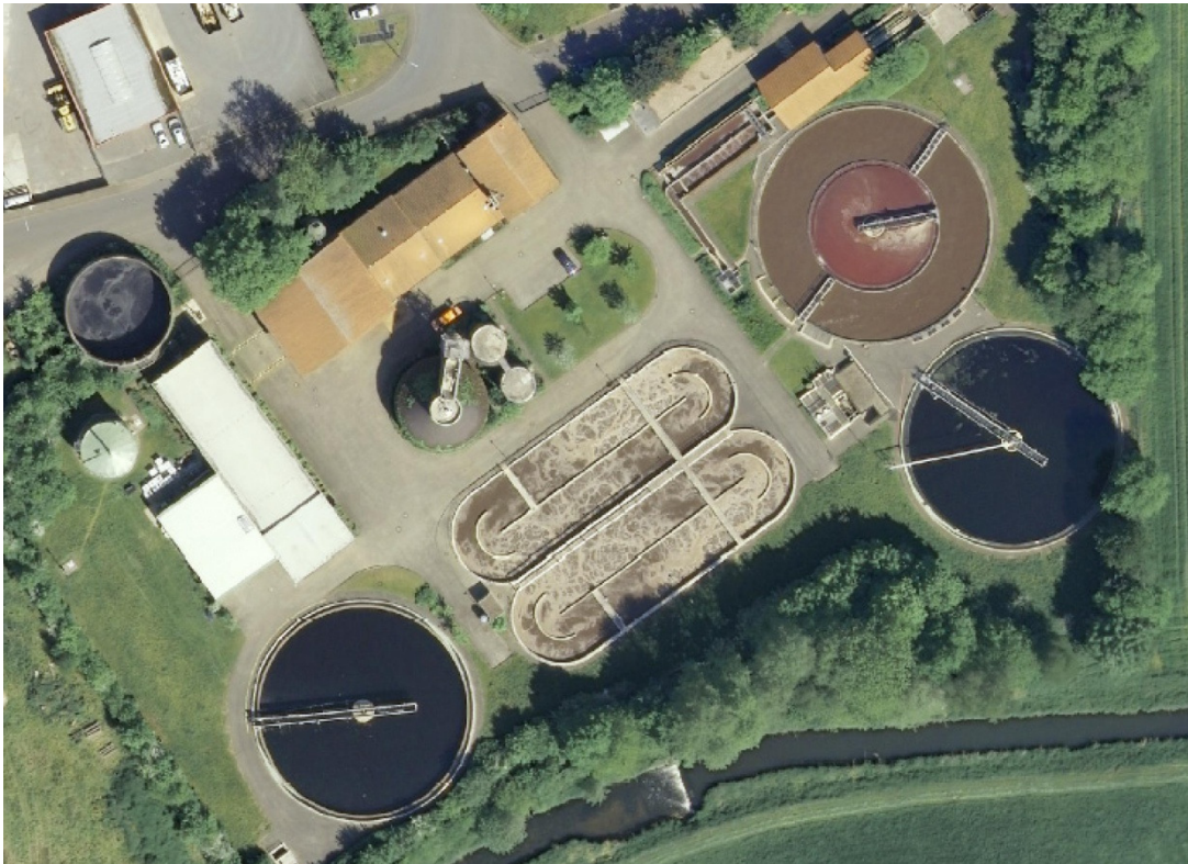
Abbildung 1: Luftbild der Kläranlage Harsewinkel
