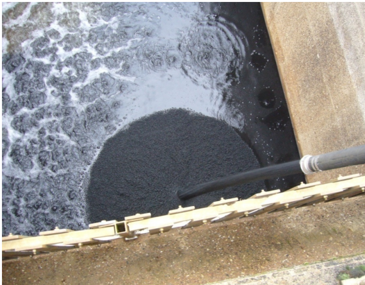
Abbildung 18: Verbandsklärwerk Obere Lutter – Füllung der Filterzelle mit granulierter Aktivkohle
