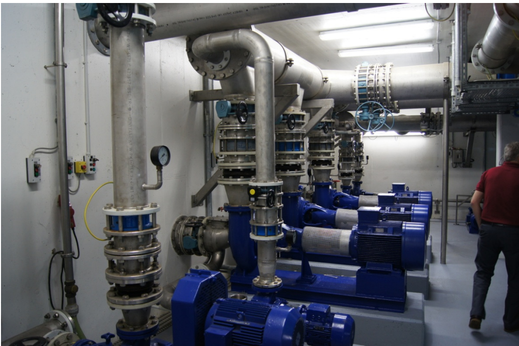
Abbildung 4: Zulaufpumpen Filterbeschickung
