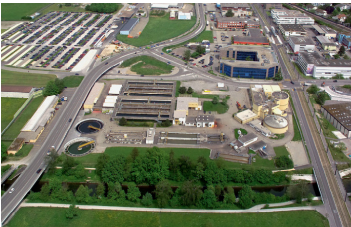
Abbildung 17: Anwendung der Pulveraktivkohle - Versuche auf der Kläranlage Kloten – Schweiz / Luftbild
