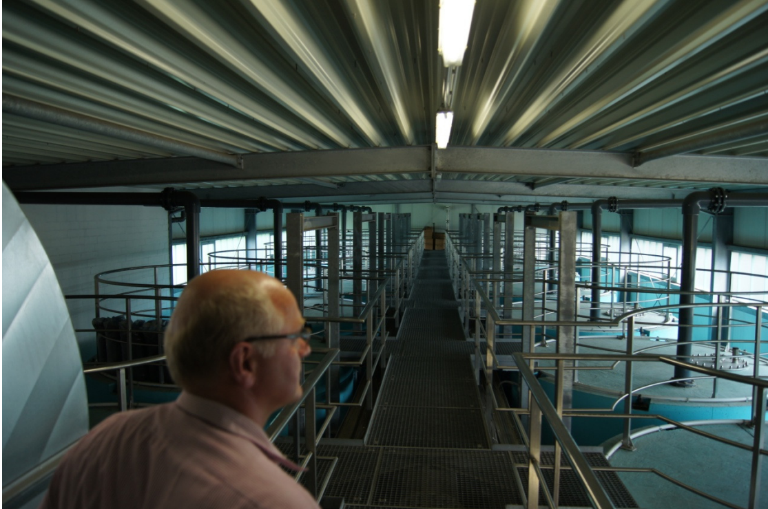
Abbildung 7: Filtration Begehung im Deckenbereich (oben)
