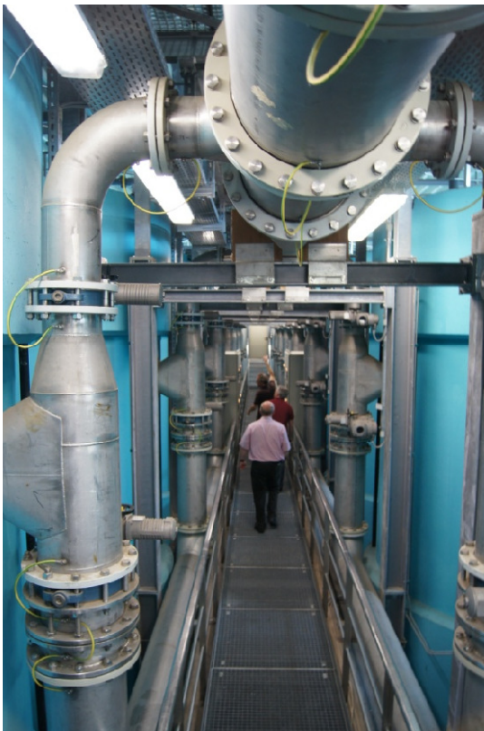
Abbildung 6: Filtergalerie
