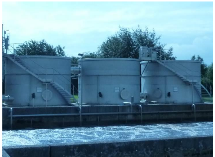
Abbildung 4-6: PAK Kontaktbecken KA Schwerte
