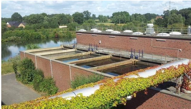
Abbildung 4-3: Aktivkohlebecken KA Obere Lutter [Quelle: www.mikroverunreinigungen.de/obere-lutter/ , aufgerufen am 17.10.2013]
