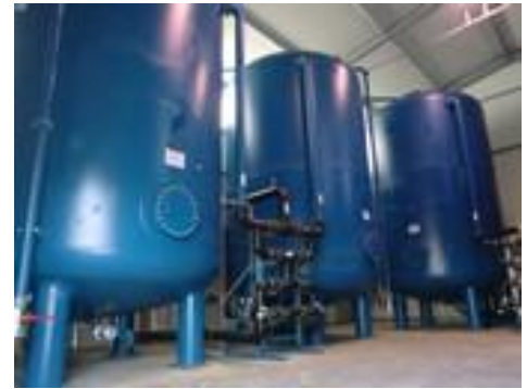
Abbildung 4-4: Aktivkohle-Kessel [ www.zueblin-umwelttechnik.com , aufgerufen am 17.10.2013]
