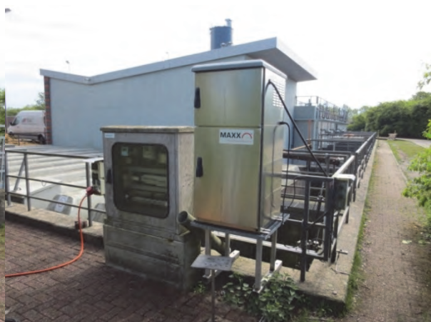
Ablauf Nachklärung (rechts)
