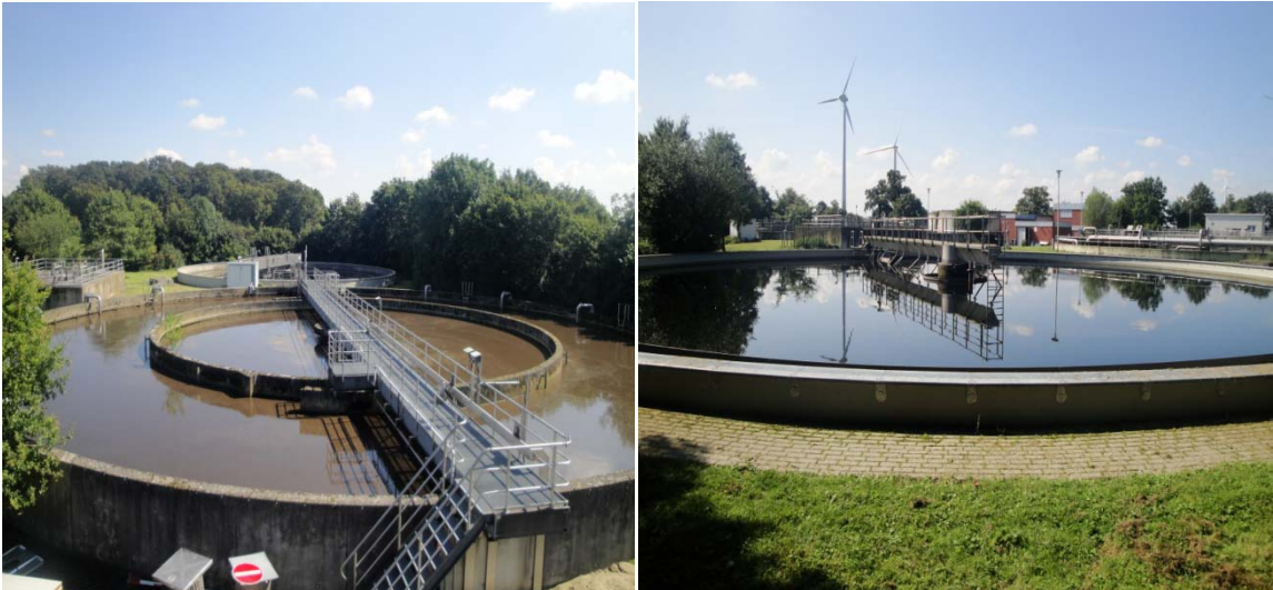
Abbildung 1: Kläranlage Sendenhorst, Belebungsbecken 2 (links)
