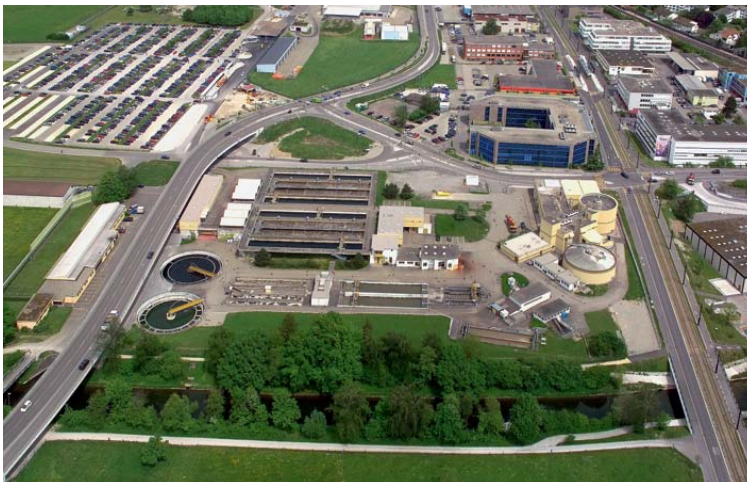
Abbildung 14: Anwendung der Pulveraktivkohle - Versuche auf der Kläranlage Kloten – Schweiz / Luftbild
