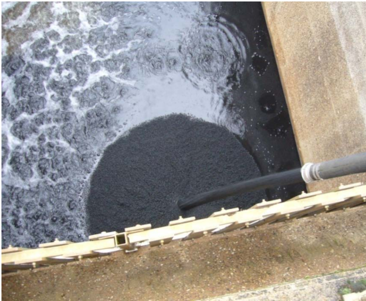
Abbildung 15: Verbandsklärwerk Obere Lutter – Füllung der Filterzelle mit granulierter Aktivkohle
