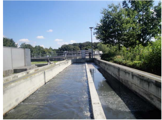
Abbildung 4: Kläranlage Sendenhorst, Sandfang (rechts)
