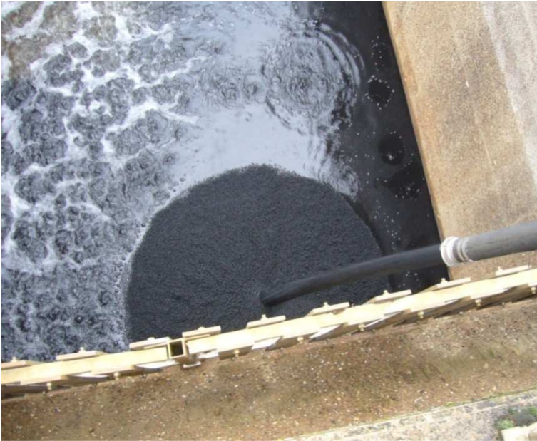
Abbildung 14: Verbandsklärwerk Obere Lutter – Füllung der Filterzelle mit granulierter Aktivkohle
