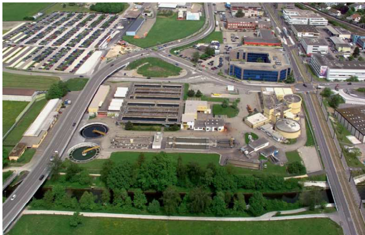
Abbildung 13: Anwendung der Pulveraktivkohle - Versuche auf der Kläranlage Kloten – Schweiz / Luftbild
