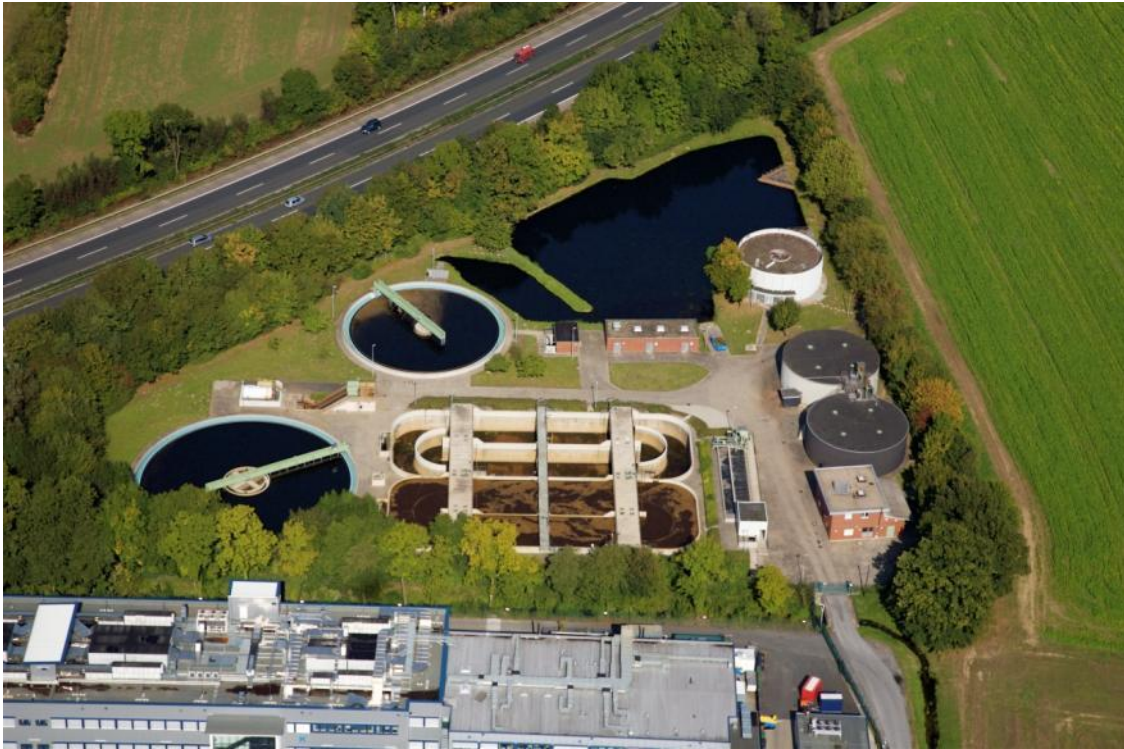
Abbildung 1-2: Luftbild der Kläranlage Münster-Geist (Quelle Tiefbauamt Stadt Münster)
