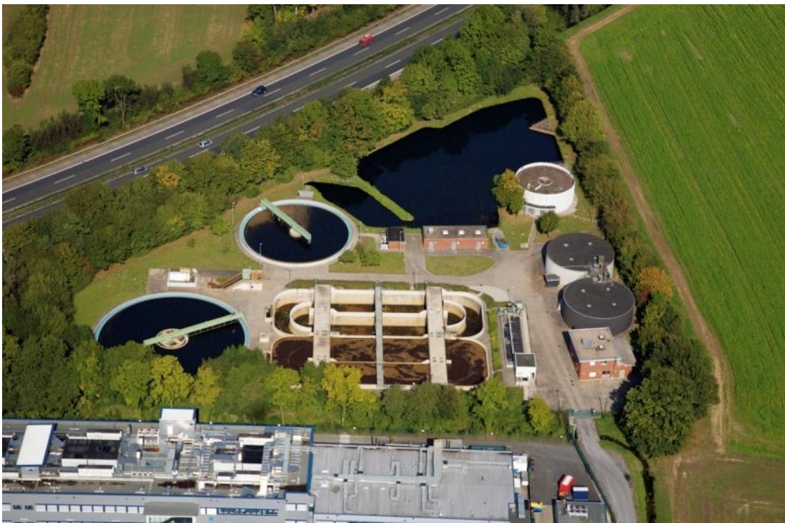
Abbildung 2-1: Luftbild der Kläranlage Münster-Geist (Quelle Tiefbauamt Stadt Münster)
