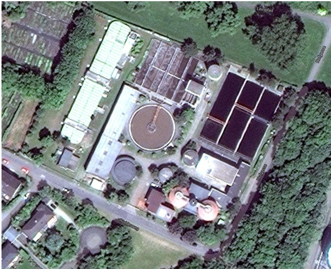
Abbildung 1-2: Luftbild der Abwasserreinigungsanlage Wesseling (Google Maps)
