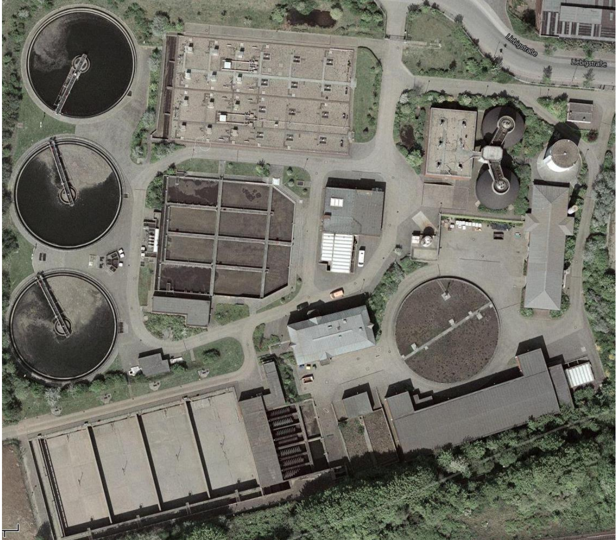
Abbildung 3-1: Übersicht Kläranlage Duisburg Hochfeld (Quelle: Google Maps)
