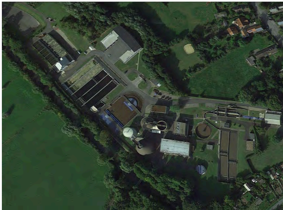
Abbildung 1: Luftbild der Kläranlage Ahlen
