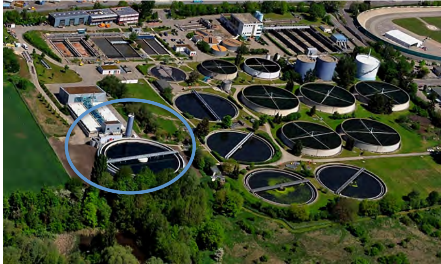
Abbildung 12: Klärwerk Böblingen Sindelfingen, PAK Anlage in Markierung
