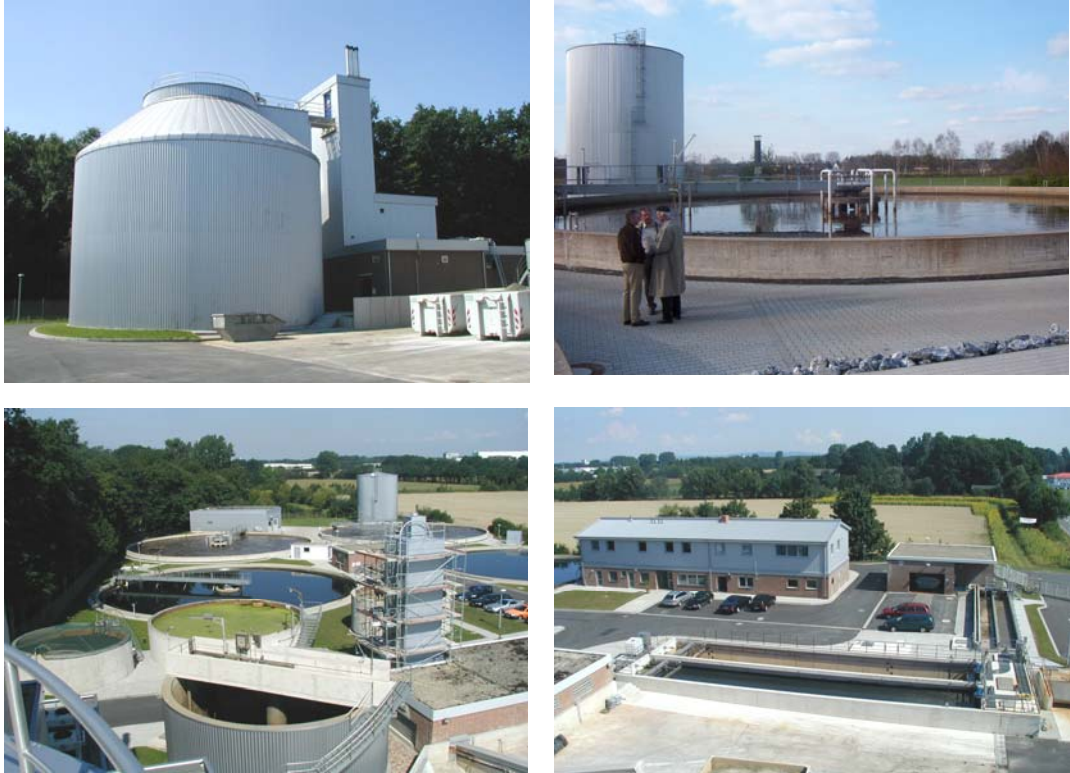
Bild 19: Sandfang, Vorklärbecken (links, oben), Faulbehälter, BHKW-Gebäude (rechts oben); Nacheindicker u.a. (links, unten), Belebungsbecken, Gasbehälter (rechts, unten)
