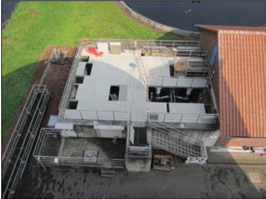
Bild 34: Dyna-Sand Carbon Filtration (KA Rietberg) (Quelle: Ingenieures. Dr. Knollmann mbH)
