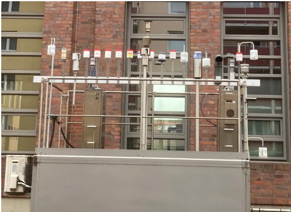
Abbildung 11: Seitenansicht der Messstation HRVS
