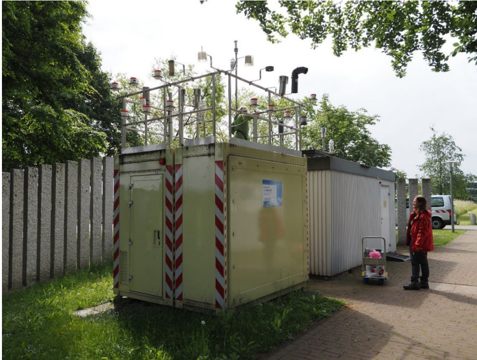
Abbildung 3: Messstation an der ELAN
