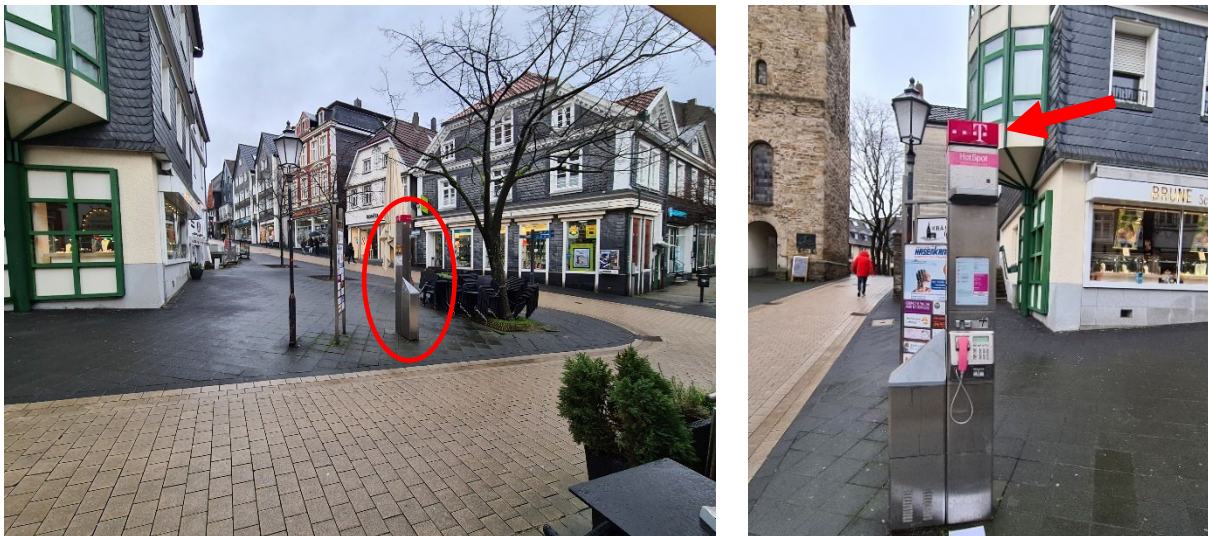
Abbildung 4.7: Standort 3: Telefonsäule am Obermarkt in Hattingen Die Antennen befinden sich in der Spitze der Telefonsäule.
