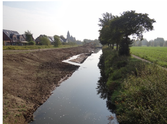
Abwärts während Renaturierung–vor Fertigstellung 2018
