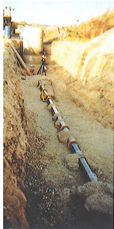
Abbildung 1: Freigelegte Leitung mit Injektionskörpern 4
