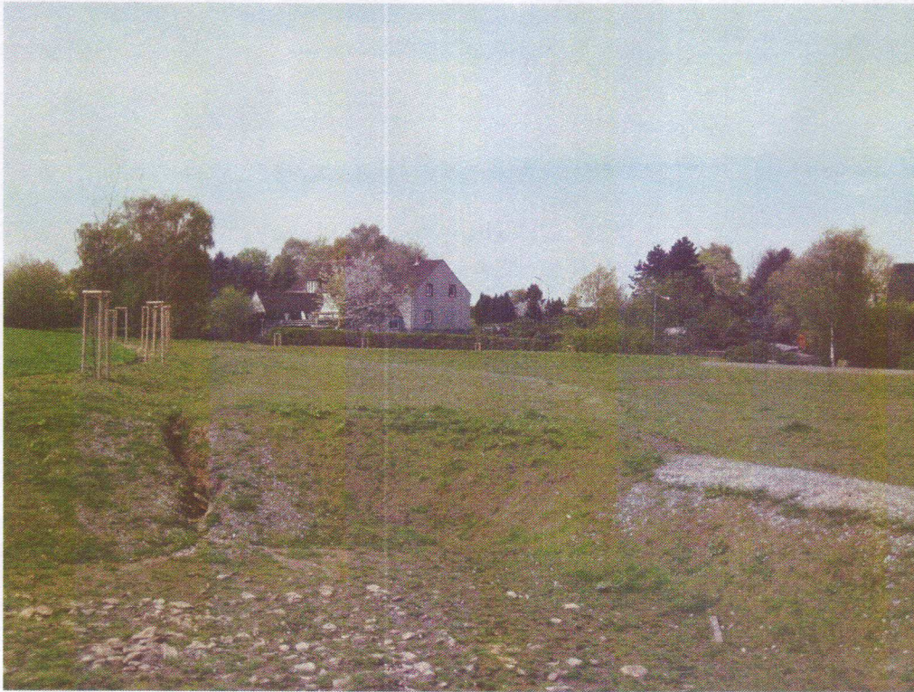
Versickerungsmulde Quartlenbecke, im Vordergrund der Schlammfang
