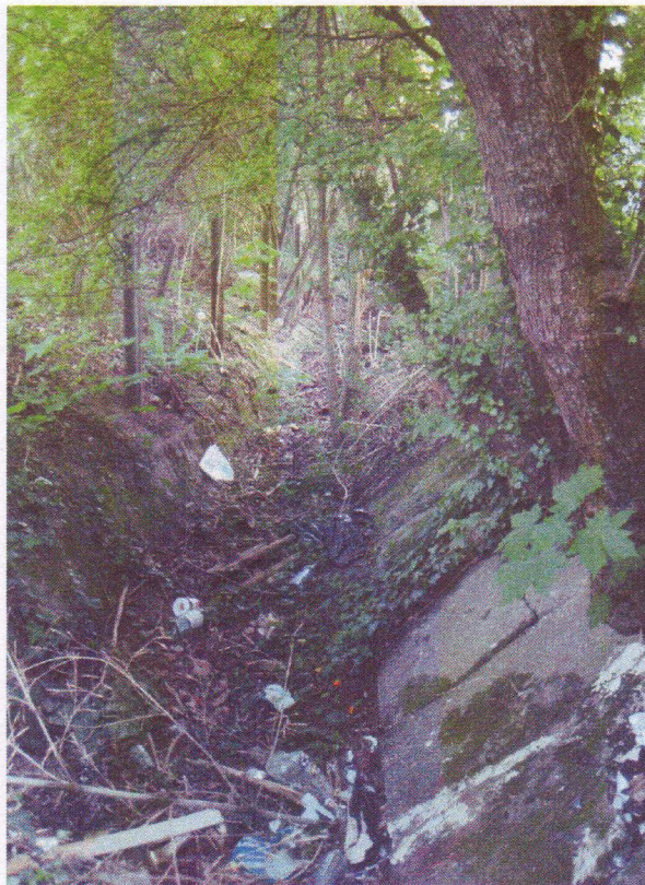
Alte Trasse der Wassergosse zwischen Bahnlinie Dorstfeld-Unna und dem Hellweg, die noch besteht, aber keine wasserwirtschaftliche Funktion mehr besitzt
