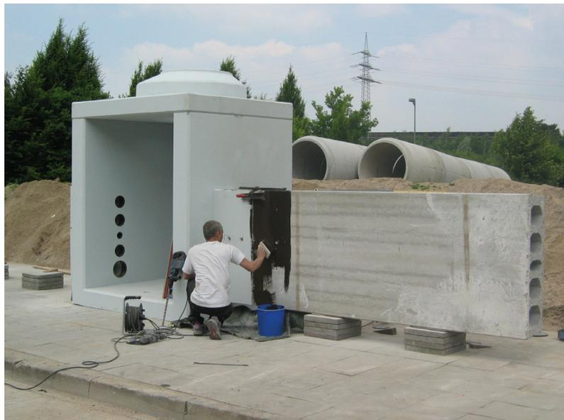
Abb. 2.2 Aufbau und Abdichtung des Systems, Quelle: Dipl.-Ing. F. Ermert
