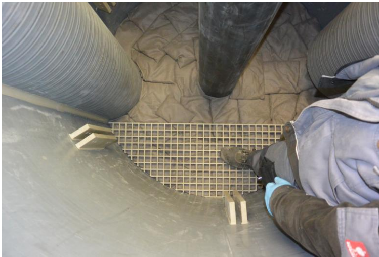
Bild 5 FiltaPex® · modular I plus 1400 (hier: Elsach-Center, Bad Urach unmittelbar vor der Auslieferung am 27.11.2013 während der Einbauphase für die obere Gitterrostlage zur Auftriebssicherung des Filters)
