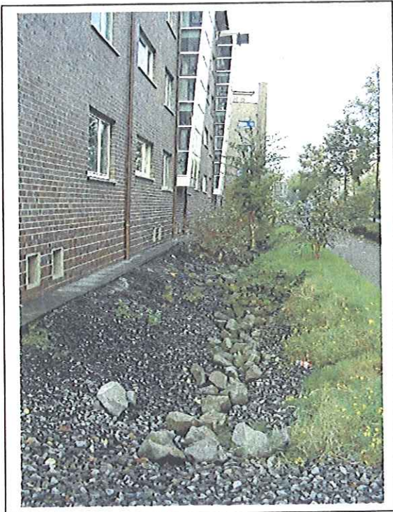
Foto 12: Versickerungsanlage an Standort 46.
