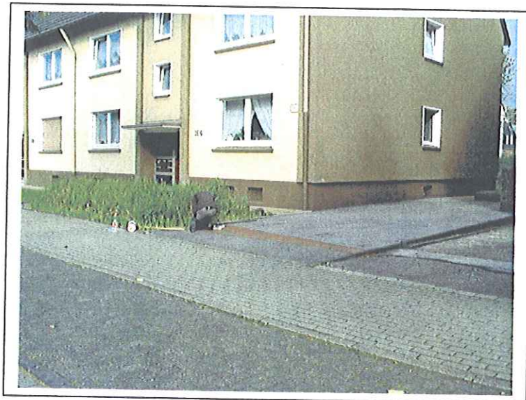
Foto 3: Versickerungsanlage an Standort 5.
