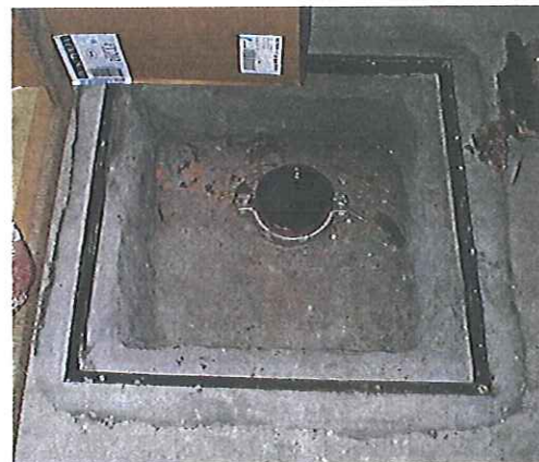
Abbildung 5.6: Revisionsöffnung der Grundleitung
