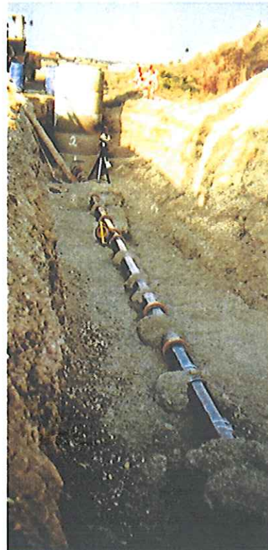
Abbildung 4.1: Freigelegte Leitung mit Injektionskörpern 9
