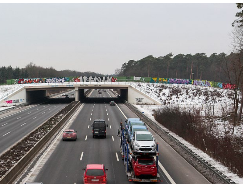
Blick auf Grünbrücke A 3 von Süden zwischen Wahner Heide und Königsforst
