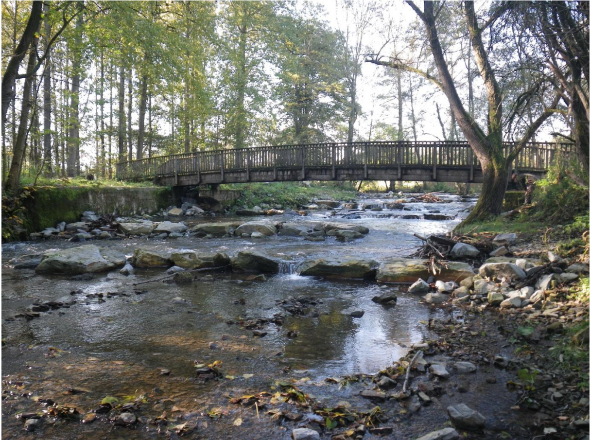
Umgebaute Wehrsituation an der Alme
