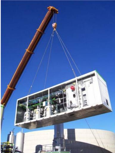
Bild 4: PSA-Containeranlage (CarboTech Engineering GmbH) BGA Pliening, Bayern
